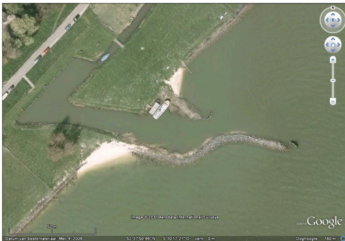
Figuur 1.1: Luchtfoto vluchthaven Wijdenes (Google Earth)
