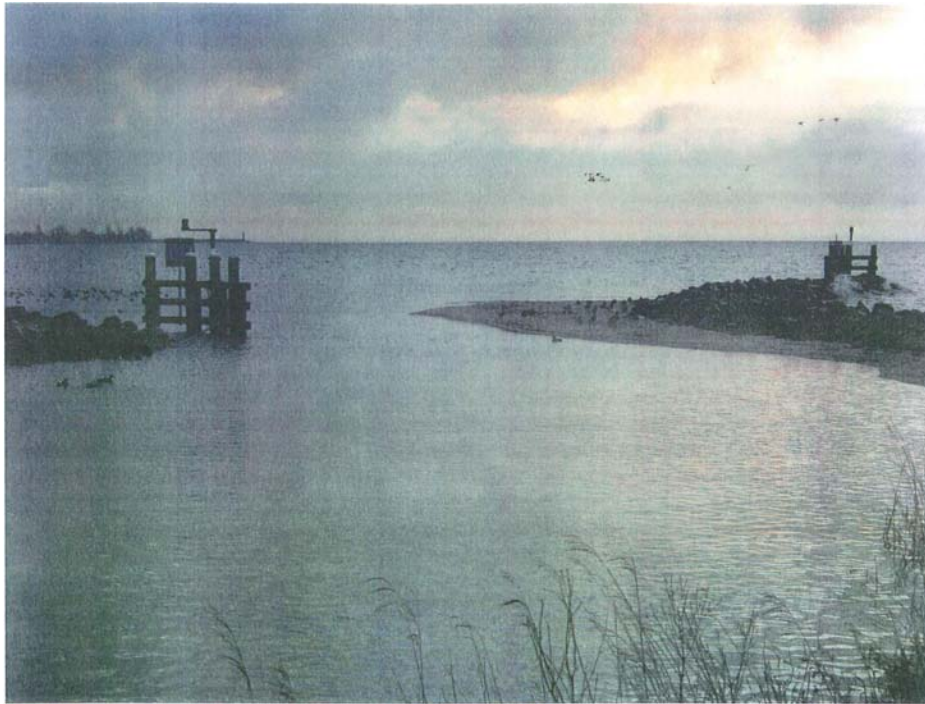
Figuur 1.3: Vluchthaven Wijdenes. Het verzandingsprobleem is duidelijk zichtbaar achter de zuidelijke golfbreker bij de havenmond.
