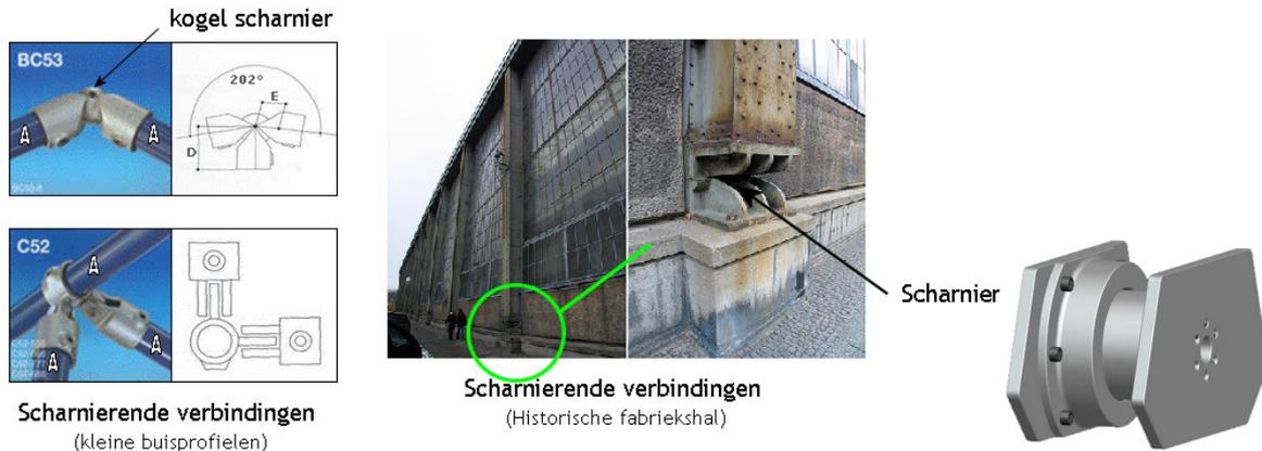
Figuur 185 - Voorbeelden 'volledig' scharnierende verbindingen
