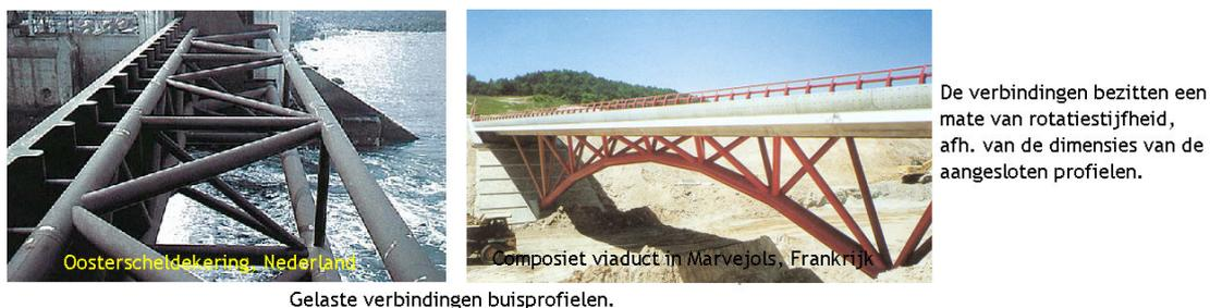
Figuur 186 - Voorbeelden gebruikelijke verbindingen buisprofielen, met een zekere rotatiestijfheid
