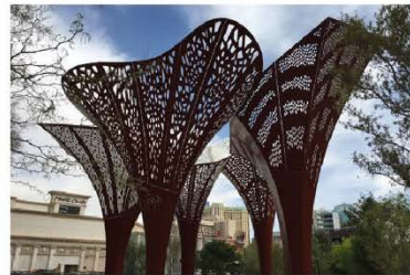
MGM Park, Shade structures, Las Vegas
