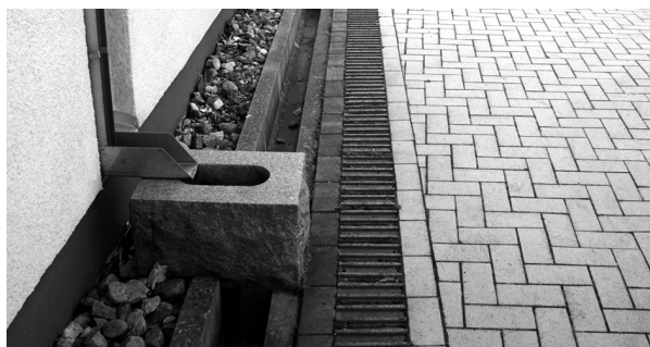
図-4 視認性を考慮した雨水のための雨樋と排水溝
