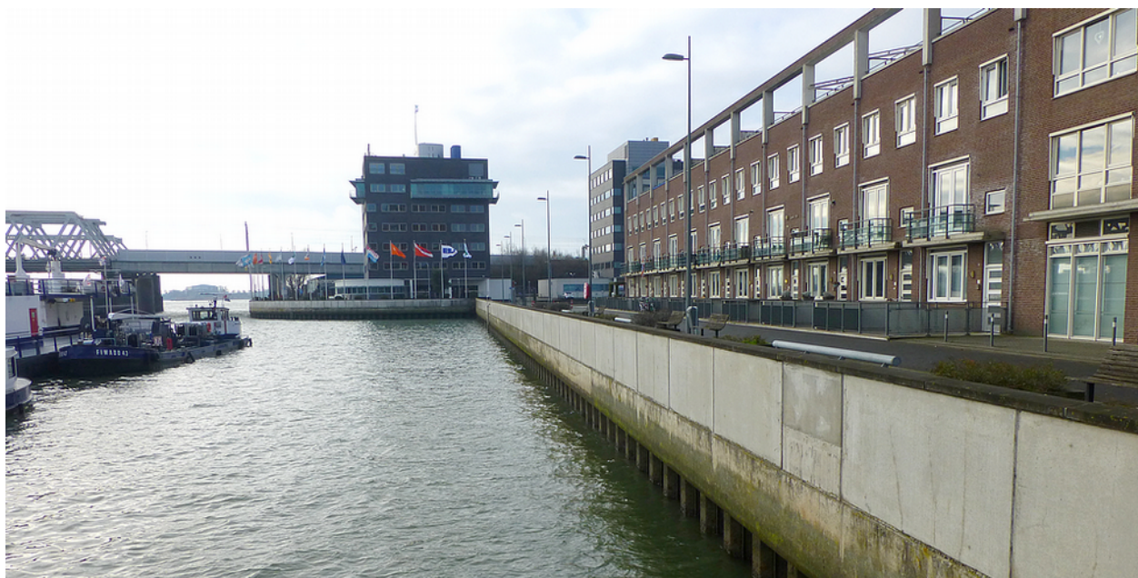
Kade in Zwijndrecht langs de Oude Maas. Onder de kade is een parkeergarage gesitueerd.
