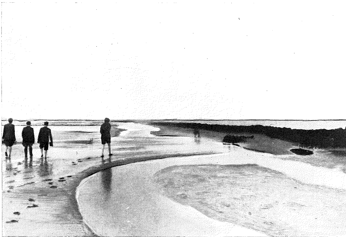
Stenen primaire dam. Door te lage en niet horizontale kruinshoogte geulvorming door overstorting bij H.W.
