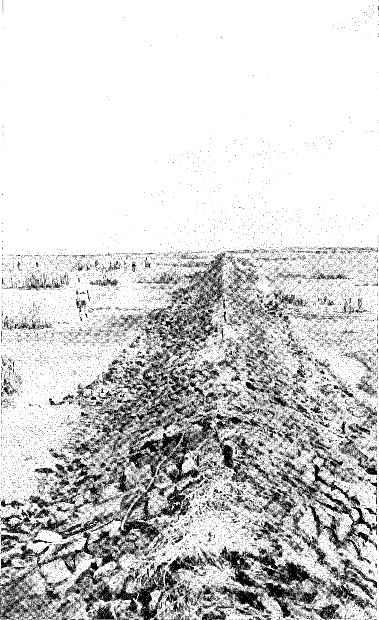
Goed afgewerkte primaire dam.
