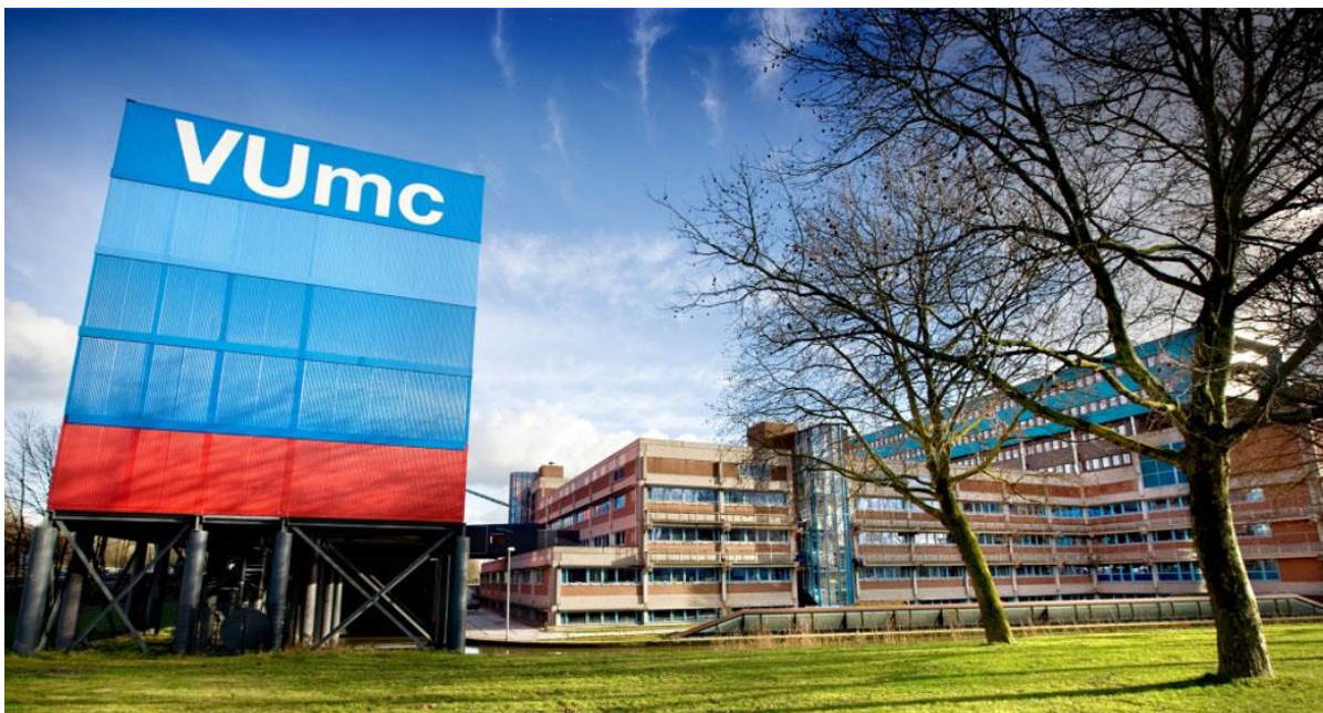
Fig 12. VUmc Hospital at the Zuidas
