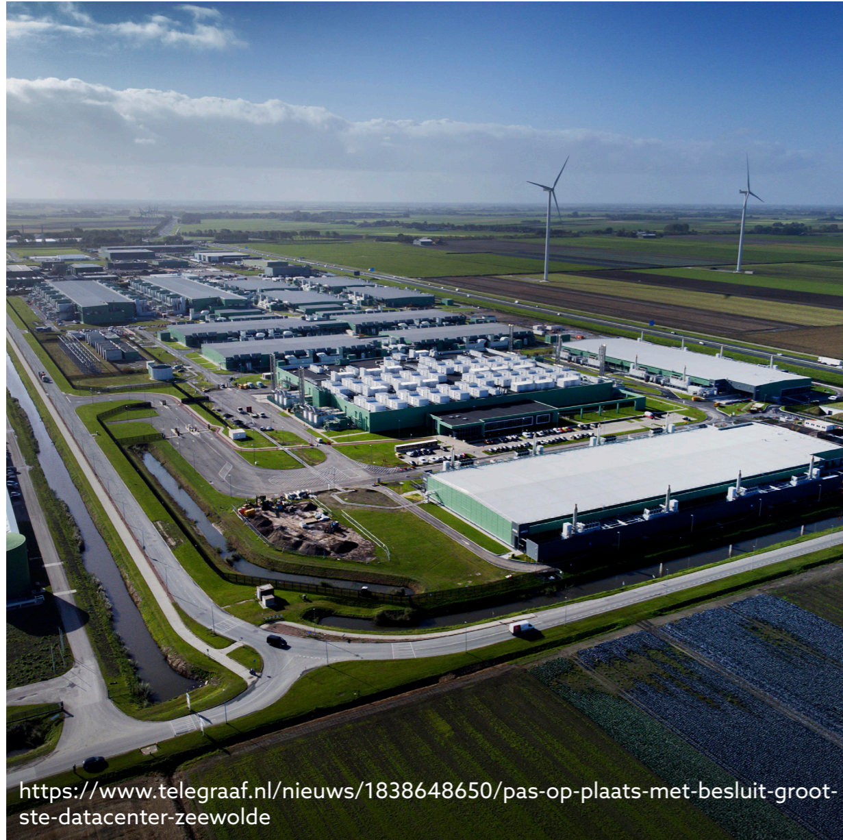
ZEEWOLDE DATACENTRE META
