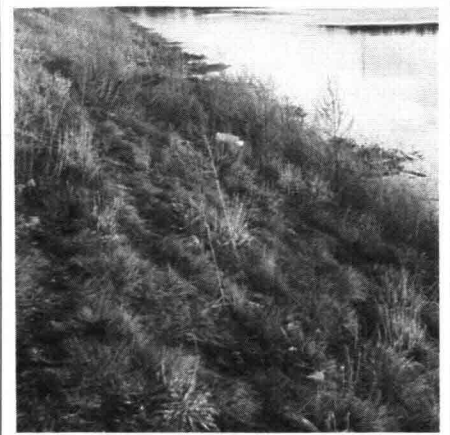
11 Dezelfde oeverbeschermingsconstructie langs de rivier 'De Nete', twee jaar na aanleg
