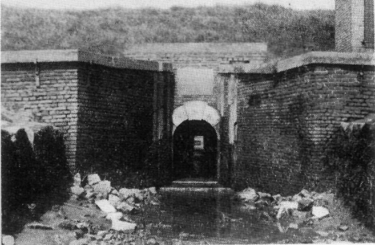
fig. 152. Suatiesluis van de cal. Onrustpolder aan de rivierzijde (1960).
