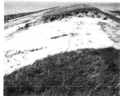
fig. 87. Oud Noord-Beveland- polder (Glasjesnol). Dijksverhoging is weggespoeld.
