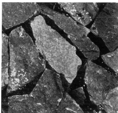
fig. 122. Lessinesche steenglooïing.
