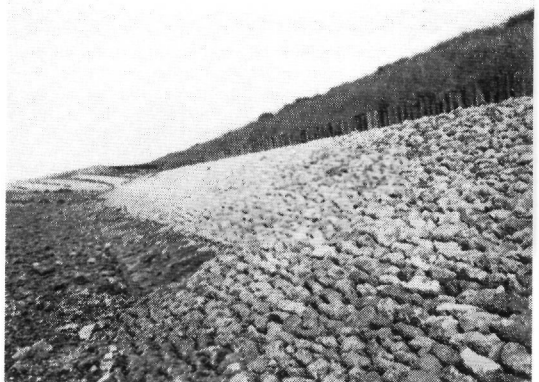
fig. 123. Vilvoordse steenglooïing aan de cal. Vlietepolder (nieuwe Westnol).
