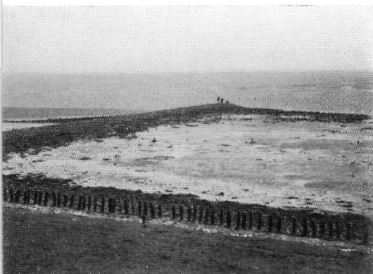
fig. 111. In 1859 aangelegde „afsluitdam” ten oosten van Colijnsplaat, opname 1960.
