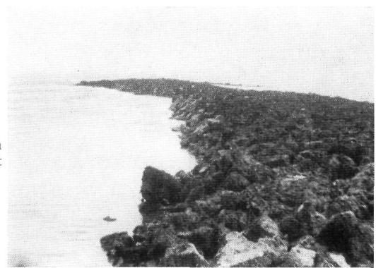
fig. 63. Beschadigde dam bij de oeverval van 28 maart 1951 aan de cal. Leendert Abrahamspolder.
