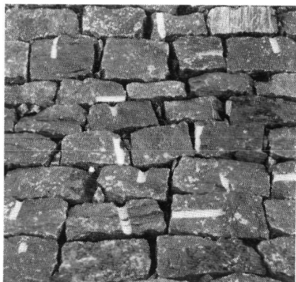
fig. 124. Glooïing van „Petit Granit” aan de Torenpolder.
