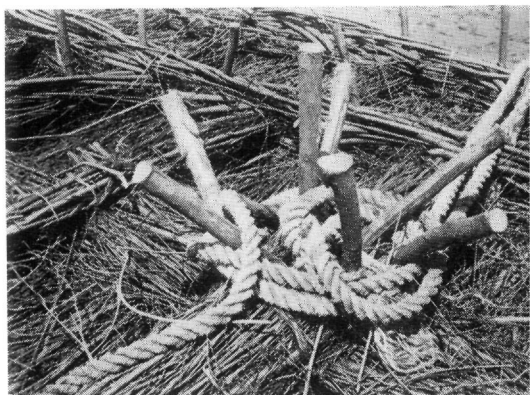
fig. 113. Detailopname van een z.g. „prop”, een „bolder” van een zinkstuk.
