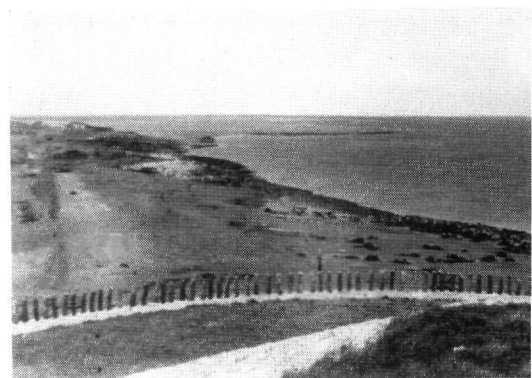
fig. 61. Oeverval van 10 januari 1939 aan de Al te Kleinpolder. Een oppervlakte van ca 4,5 ha verdween onder L.W., opname 1951.
