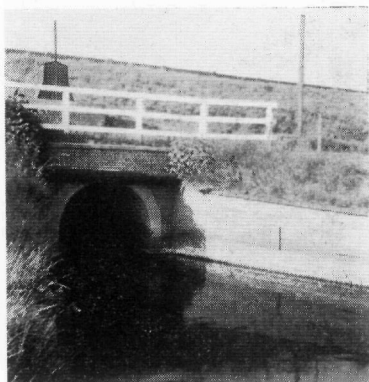
fig. 154. Suatiesluis te Colijnplaat aan de landzijde (1958).
