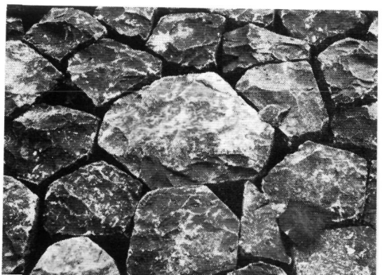
fig. 126. Basaltglooïing (nieuw), nog „ongestopt”.
