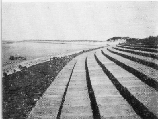
fig. 132. Trapjesbetonglooïing (systeem Leendertse) aan de cal. Onrustpolder.
