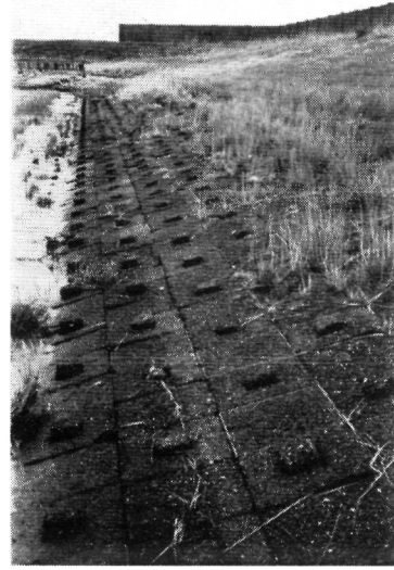
fig. 135. Spijkerlooïing (systeem de Muralt) aangelegd in 1924 aan de Oud Noord-Bevelandpolder.
