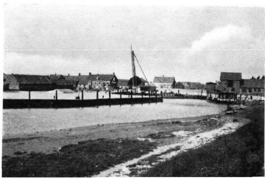
fig. 164. Overzicht van de oude haven te Kamperland.
