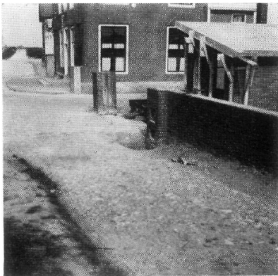
fig. 56. Dubbele coupure aan de haven te Colijnsplaat met tijdens de stormvloed van 1-2-'53 beschadigde middenpilaster.
