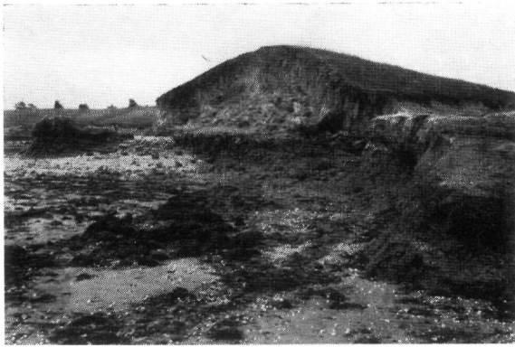
fig. 53. Overgebleven v.m. zeedijk (nol) van de v.m. Al te Kleinpolder. De kern is het restant van de zeedijk van Noord-Beveland voor 1530.
