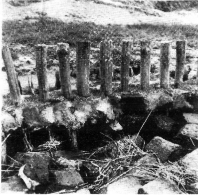
fig. 85. Nieuw Noord- Bevelandpolder. Beschadiging glooiing bij dijkpaal 2,50.
