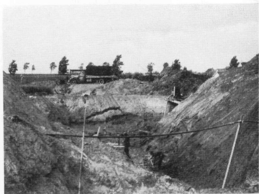
fig. 159. Doorgraving binnendijk tussen de Geersdijkpolder en de Willempolder voor het leggen van een der acht duikers voor de nieuwe afwatering (1960).
