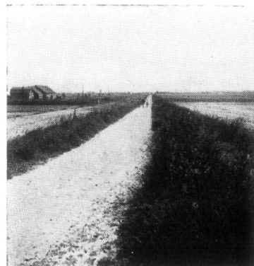
fig. 76. Afgegraven dijk tussen de Willem-Adriaanpolder en de Westpolder (Galgendijkweg ?)
