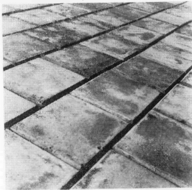
fig. 132. Trapjesbetonglooïing (systeem Leendertse) aan de cal. Onrustpolder.
