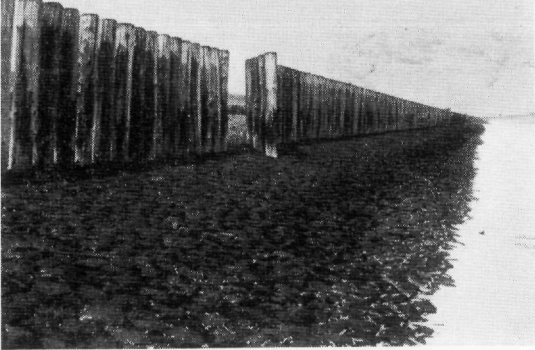
fig. 127. Basaltglooïing met paalrij en door- gang aan de cal. Anna Frisopolder.
