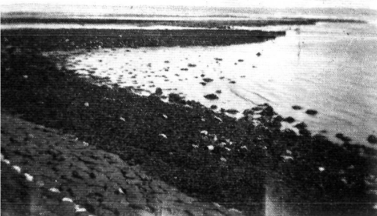
fig. 101. Verbindingsdammen van het noordelijk oeverwerk aan de cal. Leendert Abraham-polder bij L.W. (1951).
