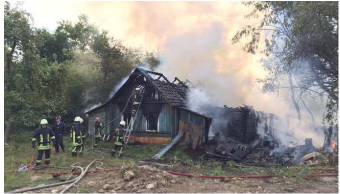
FIGURE 24. HOUSE FIRE IN RINKTINĖS st., 2015 SOURCE: 15min
