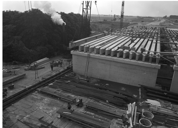
Figure 2.5: Construction of a T-beam bridge deck (Vechtbrug 1962) (Rijkswaterstaat 2020)
