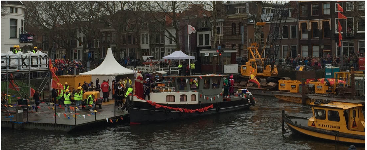
Figure 3: Restoration of Quay walls Bemuurde Weerd, Utrecht (Kleybruggen, 2017)
