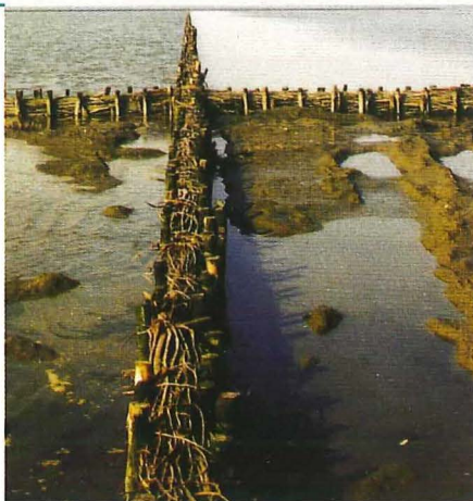
Rijshoutdammen zorgen voor rust in het water, zoals is te zien in het verschil in golven links en rechts van de dam.
