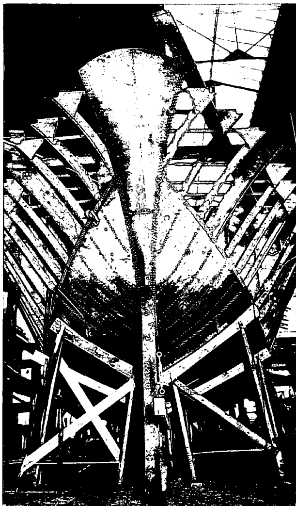
Fig. 5. Ein PT 20 im Bau, Ansicht gegen das Vorschiff. Vue de l'avant d'un PT 20 en construction.
