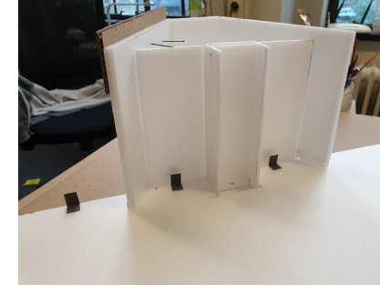
Fixatie verticale delen met stalen L-profielen
