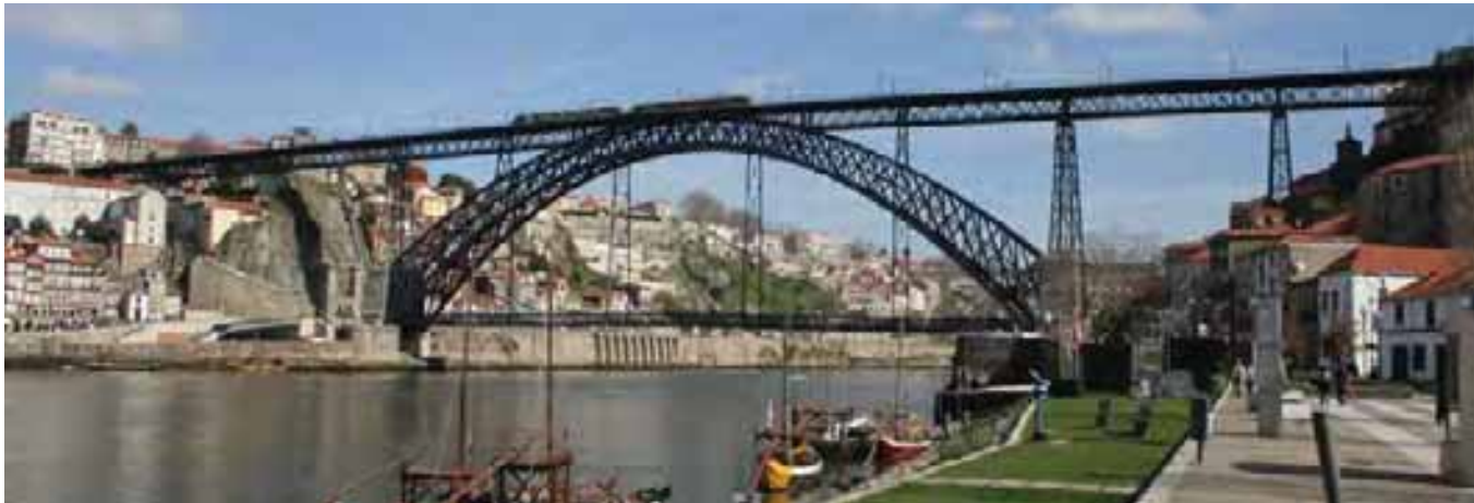
Ponte Luis, Porto
