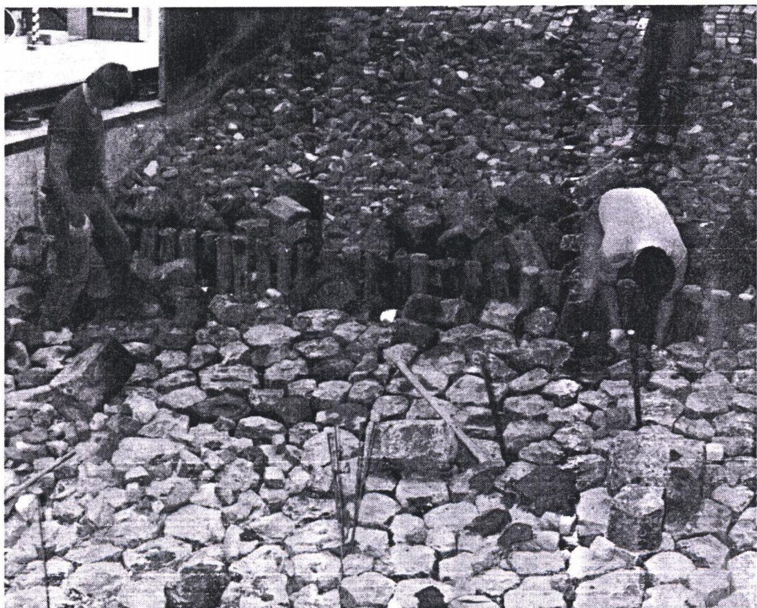
Bouw van de basaltglooiing in de deltagoot.
