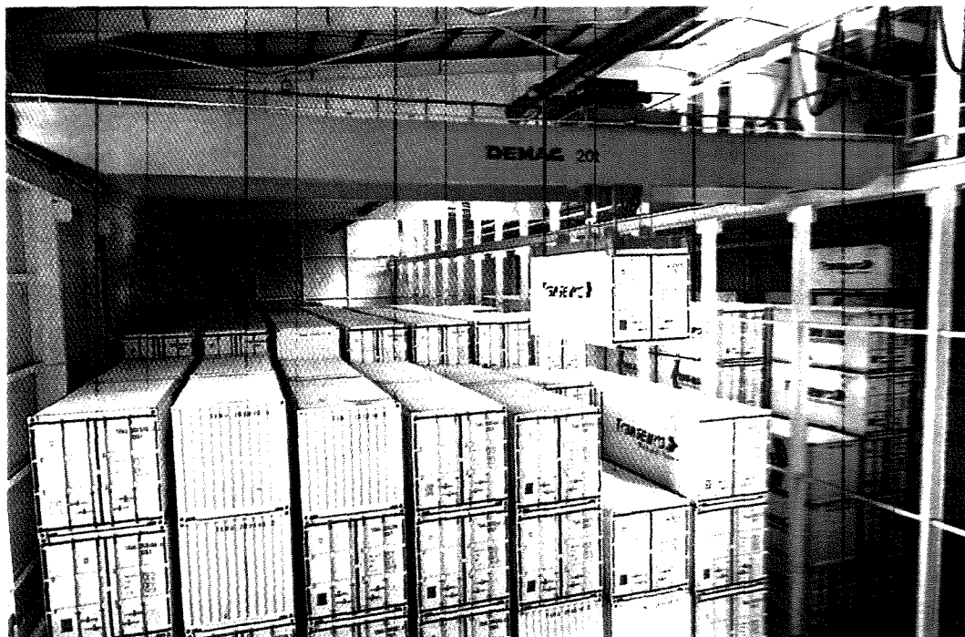
Figuur 8.3: double girder crane met een capaciteit van 20 ton specifiek voor containers
