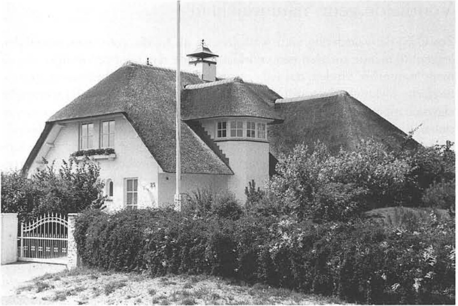
Villa in Noordwijk aan zee. 'Natuurlijke' materialen en 'organische' vormen geven een indruk van verbondenheid met de natuur, die nog versterkt wordt door de omringende beplanting.
