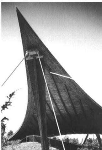
Figure 1.3: Timber hyper shell in Dortmund (Holzbau Konstruktionen)
