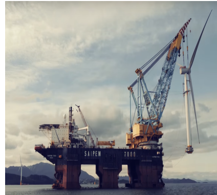
(d) Complete turbine lift (source-Hywind)
