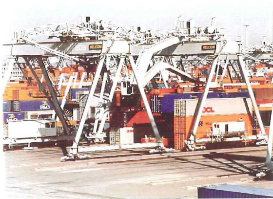
Figuur 7 Automatic stacking crane
