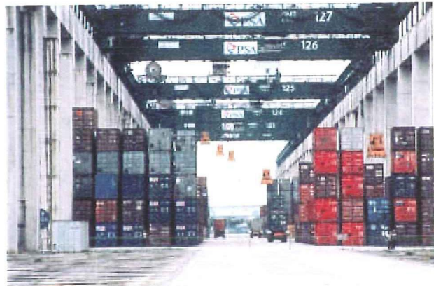
Figuur 8 Overhead brigde crane
