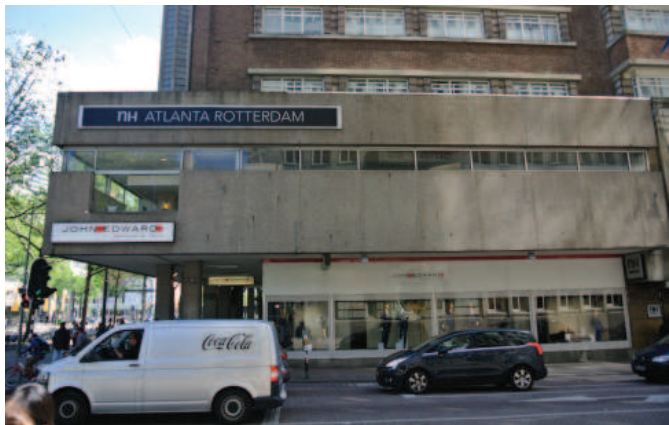
Figuur 4.56 & 4.57: Grand Garden Restaurant Aert van Nesstraat & betonnen uitkraging NH Hotel Atlanta (Auteur, 2015)
