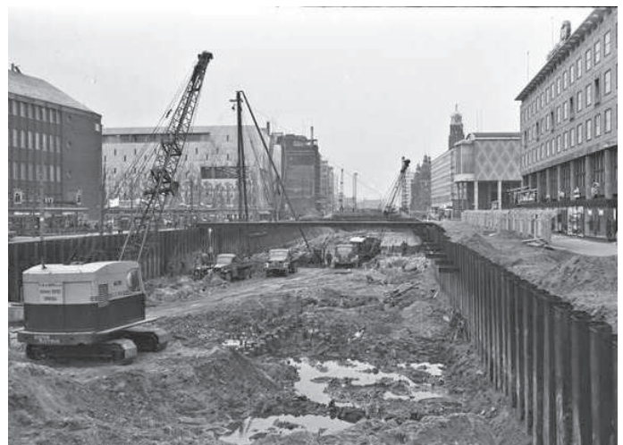
Metro system under Coolingsingel. Source: Gemeente Archief
