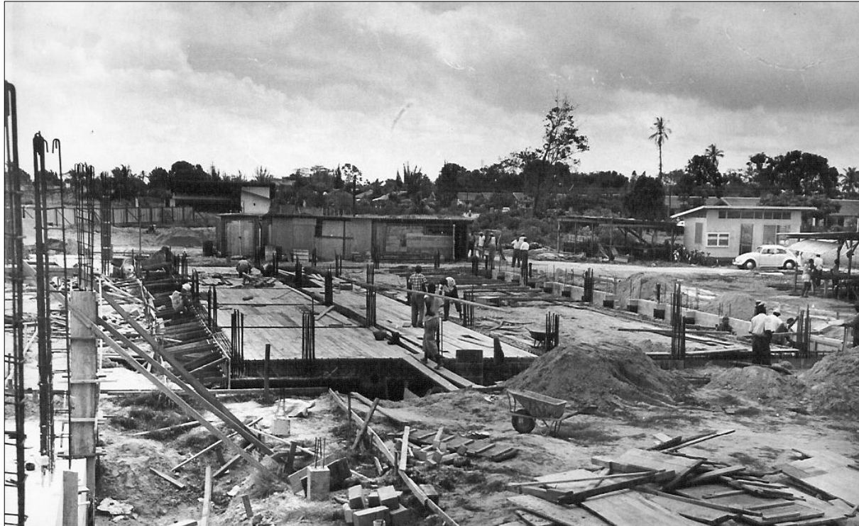
Bekisting beganegrondvloer van het Hoofdgebouw
