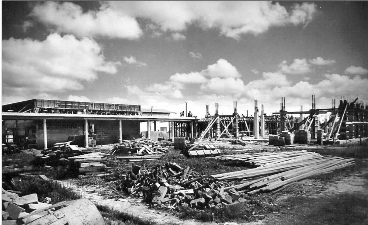
Economiegebouw (links) met overdekte verbindingsgang
