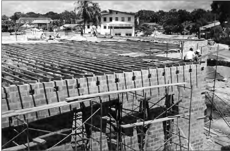
Het dak van het hoofdgebouw
