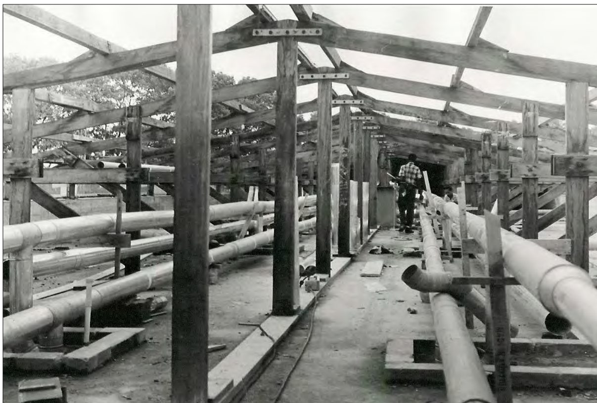
De dakspanten van de hotelvleugel worden geplaatst
