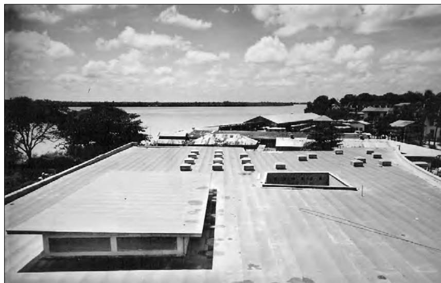
Drie maanden later is het dak gereed
