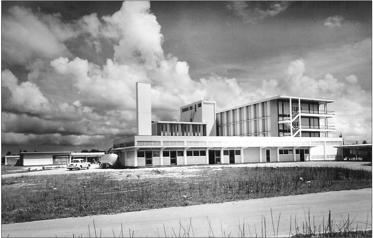
Achterzijde Economiegebouw met keuken en wasserij
