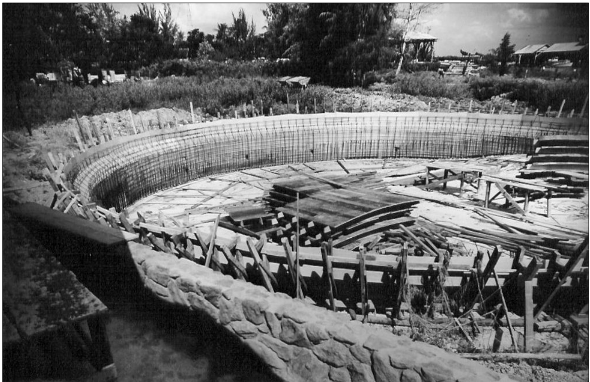
De wapening en bekisting van het zwembad worden aangebracht
