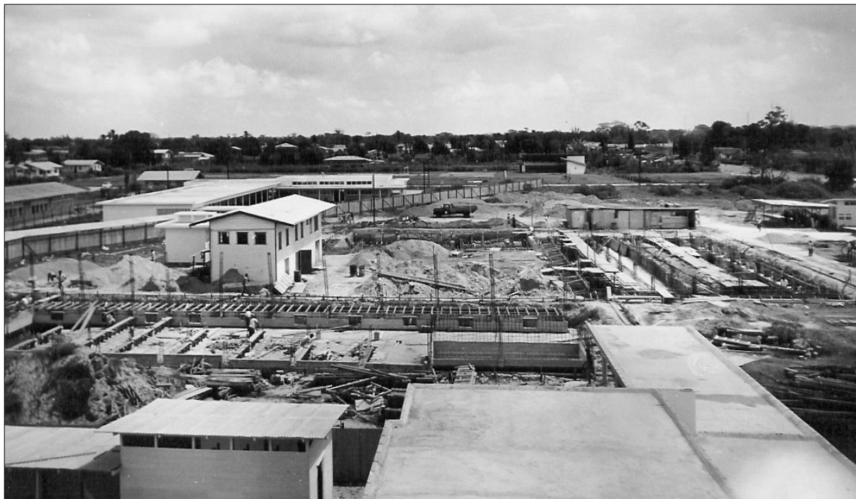
Overzicht vanaf de bovenste galerij van het Zusterhuis
