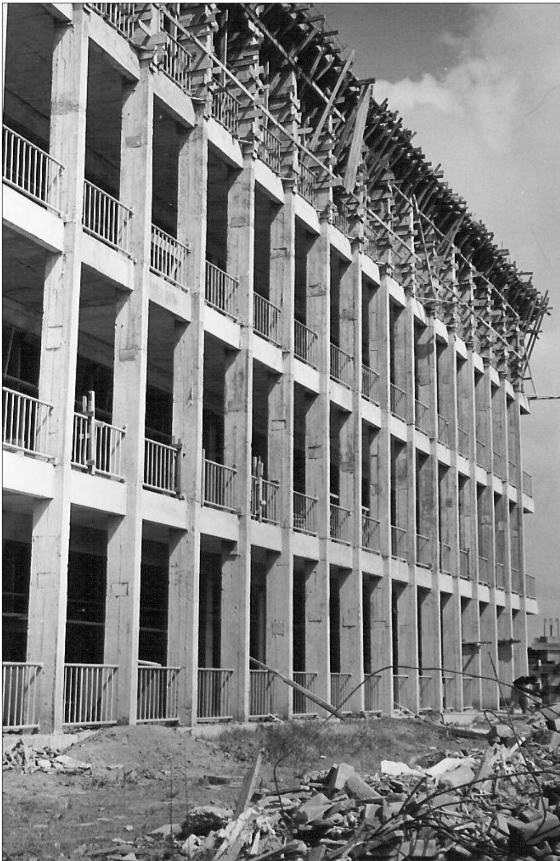
De imposante voorgevel
