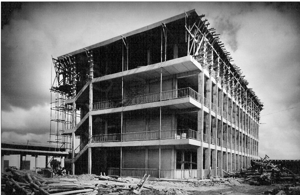
De bouw vordert gestaag
