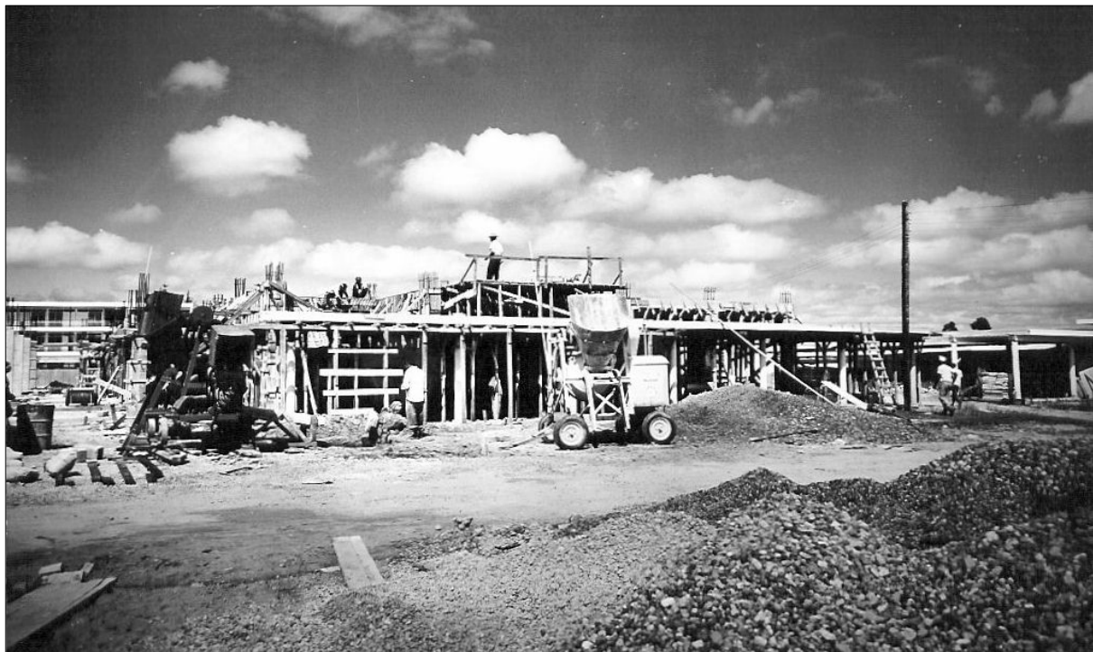
Behandelvleugel: de eerste verdieping is stortklaar
