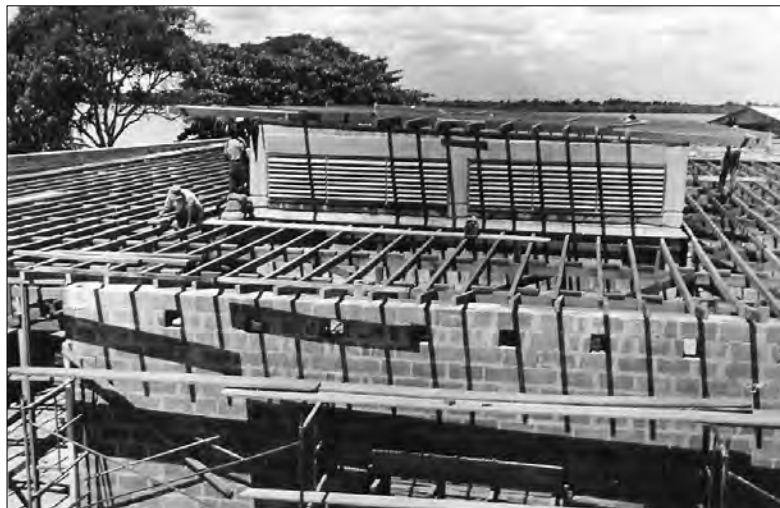
De dakkapel voor de ontluchting wordt aangebracht
