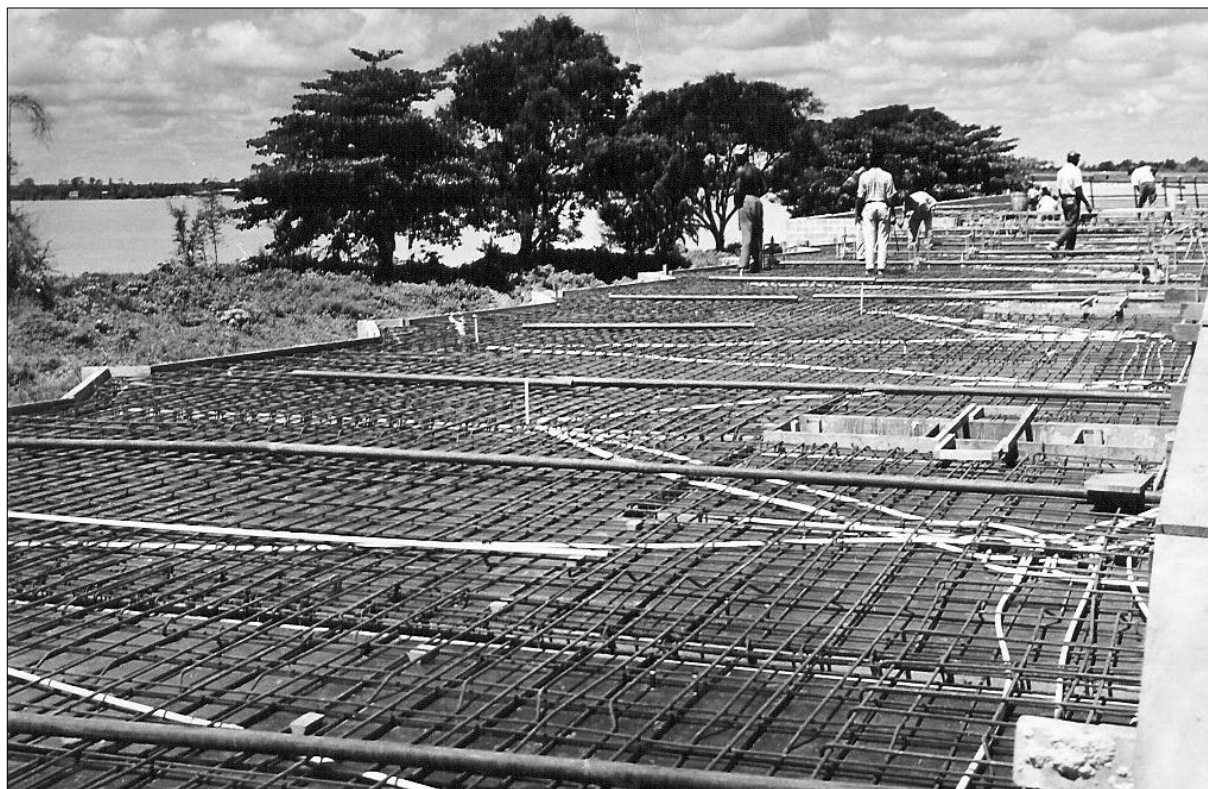
De wapening van de vloer van de 2 e verdieping van de hotelvleugel is klaar
