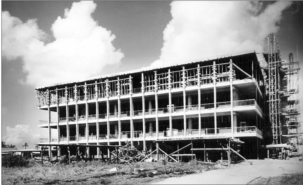
De voorgevel wordt afgewerkt
