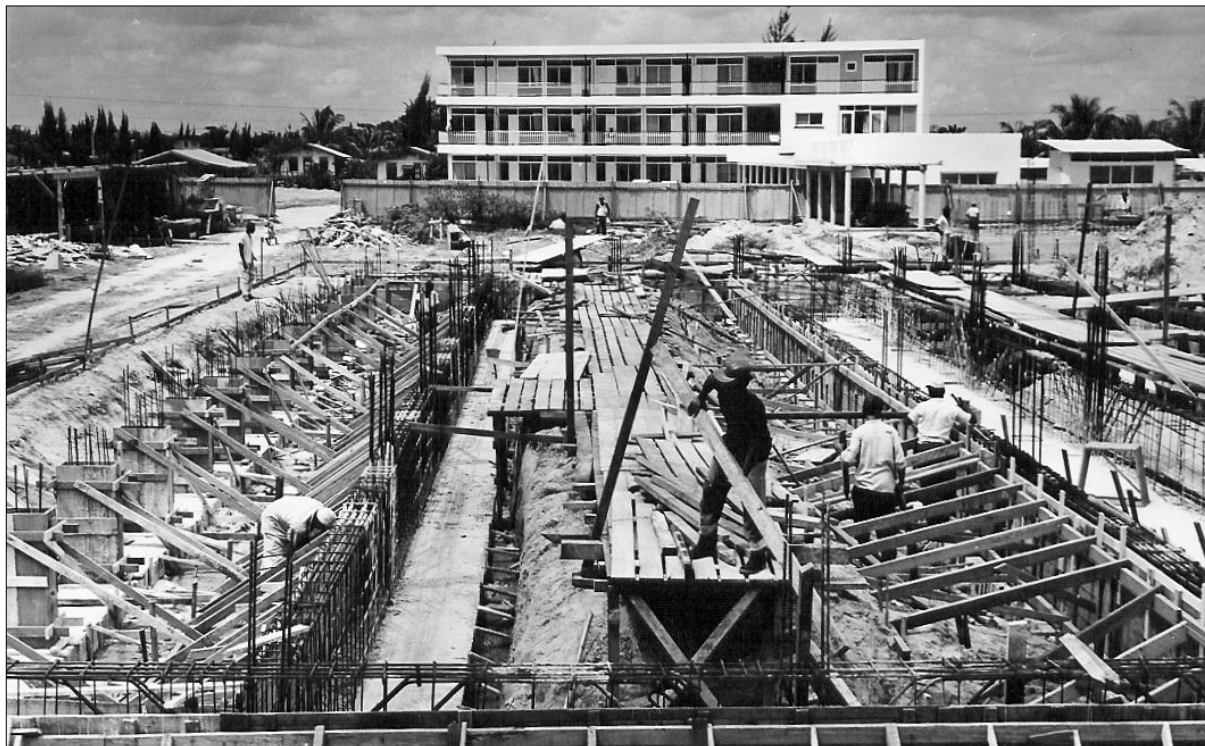
Fundering voor het Hoofdgebouw
