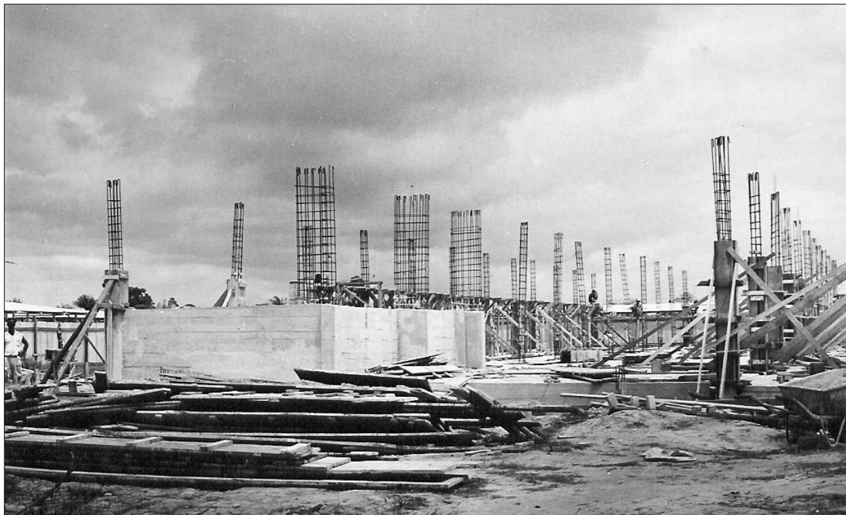
Beganegrondvloer van het Economiegebouw
