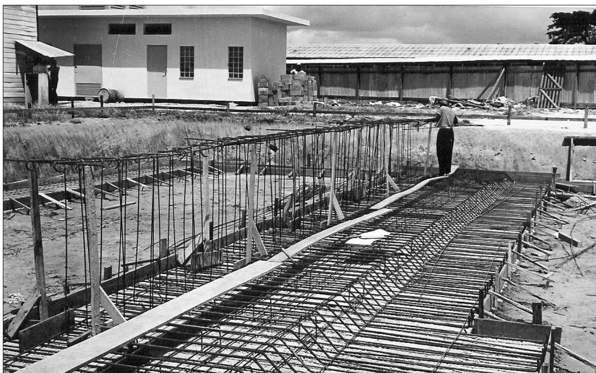
Vlechtwerk voor de fundering van de Behandelvleugel
