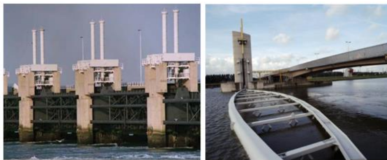
Figure 3 Vertical lifting gates. Left: Eastern Scheldt storm surge barrier(Rijkswaterstaat & Cormont, 1991). Right: Hartel Barrier (Afdeling Multimedia Rijkswaterstaat & Rijkswaterstaat, 2000)
