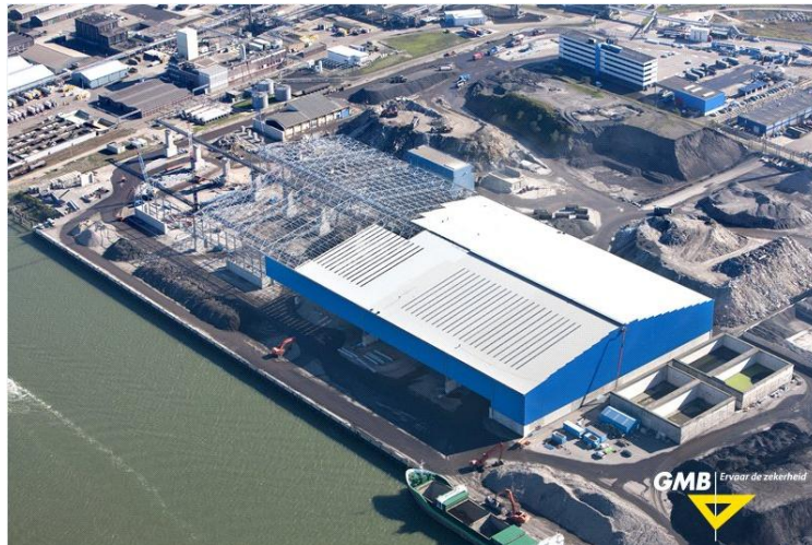
Figuur 40: De Van Bentum Recycling Centrale als voorbeeld voor hallenbouw voor de industrie
