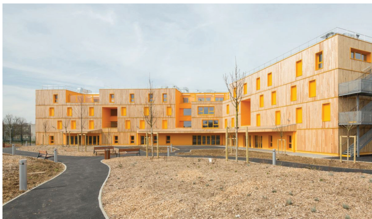
4) Morangis Retirement Home / VOUS ETES ICI Architectes
