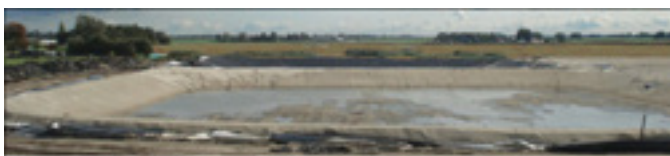
Fase 1: De sawabodem bestaat uit schoon zand, samen met regenwater een voedzame basis.
