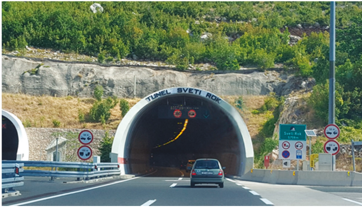
Figure 9. Sveti Rok road tunnel.
