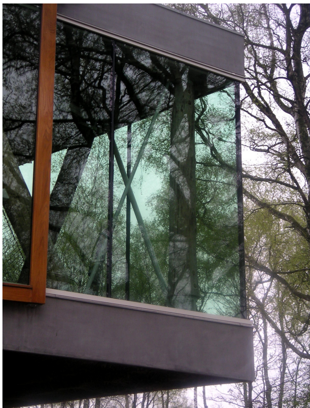
Figuur 21 Transparante architectuur is prettig vanwege de wijde uitzichten en grote hoeveelheid daglicht. Bovendien vergen gevels met veel raamoppervlak doorgaans weinig onderhoud. Daar staat tegenover dat een door glas omgeven gebouw snel kan opwarmen en afkoelen vanwege de zontoetreding en U-waarde, die hoger is dan bij een dichte gevel
