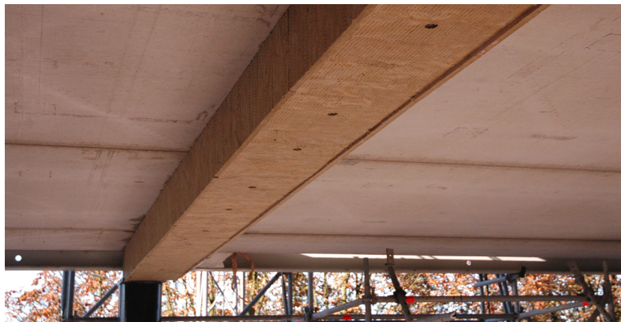
Figuur 19 Stalen balken moeten voor de brandveiligheid vaak worden bekleed met brandwerend materiaal, zoals hier geperste steenwolplaten
