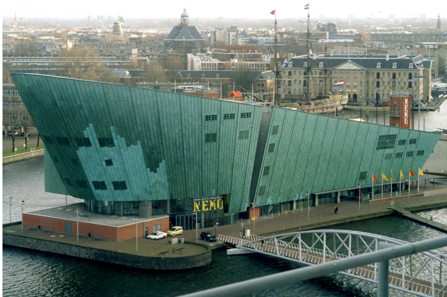
Figuur 23 Ondanks dat koper lang mee kan, was in dit geval het gepatineerde koper van Nemo in Amsterdam op een van de plekken binnen een paar jaar dusdanig aangetast, dat het moest worden vervangen
