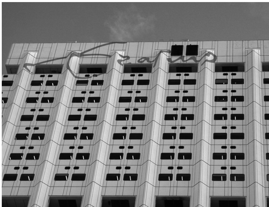
Figuur 11 De gevel van de Medische Faculteit in Rotterdam wordt bepaald door de achterliggende draagconstructie. De structuur is door de huid heen afleesbaar
