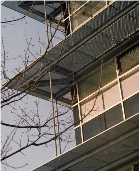
Figuur 26 Dejo-roosters zoals hier aan een gebouw in het Delftechpark kunnen een dubbele rol vervullen: behalve een loopplek voor glazenwassers en reparaties zorgen de roosters ervoor dat zonnestraling onder een bepaalde hoek het gebouw niet in kan schijnen, waardoor oververhitting kan worden voorkomen
