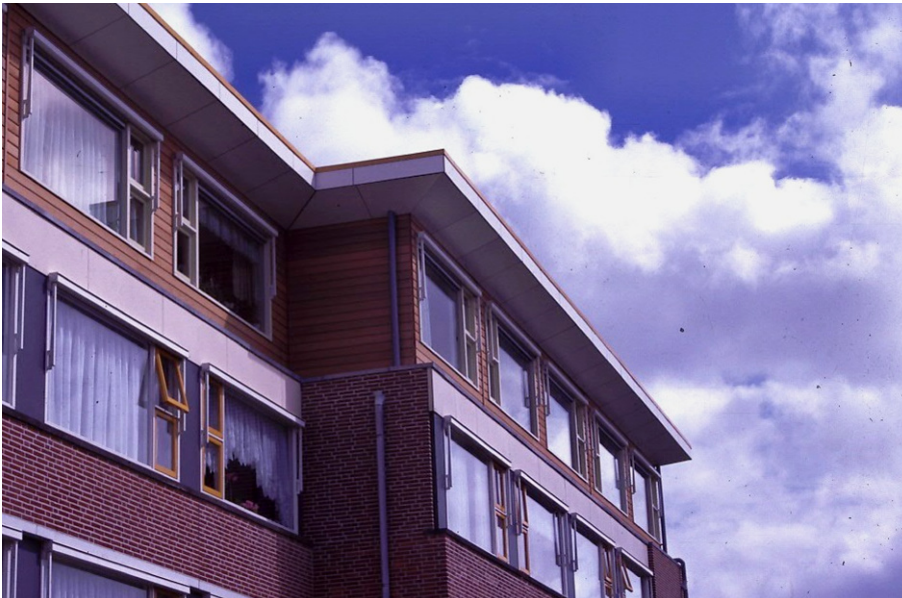
Figuur 18 Soms is het mogelijk om op een bestaande constructie een extra toplaag toe te voegen. Daarvoor moet het draagvermogen van het dak en daaronder in de ontwerpfase al enigszins groter zijn genomen dan noodzakelijk. Dit is een houtskeletbouw 'optopping' van een zorgcentrum in Loppersum
