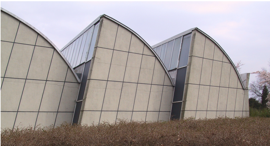
Figuur 12 Fabrieksgebouw de Ploeg in Bergeijk. Een gebouw dat in betekenis toenam omdat het behoort tot het oeuvre van de architect Gerrit Rietveld
