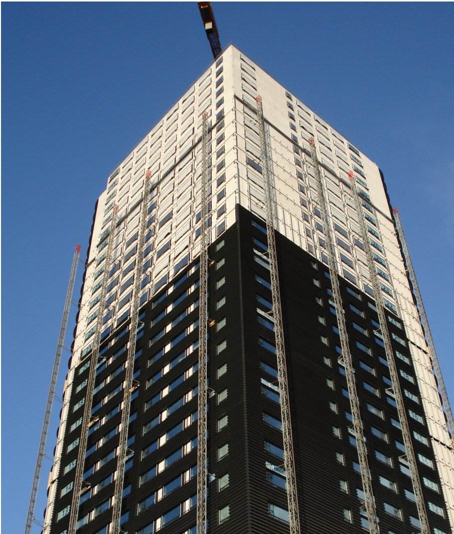
Figuur 20 Eén van de methoden om in de standzekerheid te voorzien is het toepassen van een gevelbuis-constructie. Het “Strijkijzer” in Den Haag, een 130 m hoge woontoren die op deze foto te zien is tijdens de bouw, heeft een geperforeerde prefab beton façade die dienst doet als gevelbuis. Doordat een gevelbuis-constructie de horizontale en de verticale belasting kan afvoeren, ontstaan er vrij indeelbare vloeren zonder stabiliteitswanden, windverbanden en kolommen.
