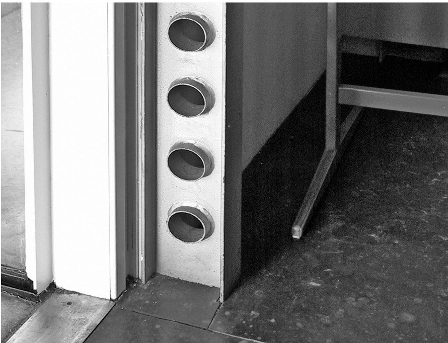
Figuur 14 In alle gevelkolommen van het Natuurkundegebouw van de TU Eindhoven zijn sparingen aangebracht voor het doorvoeren van de leidingen
