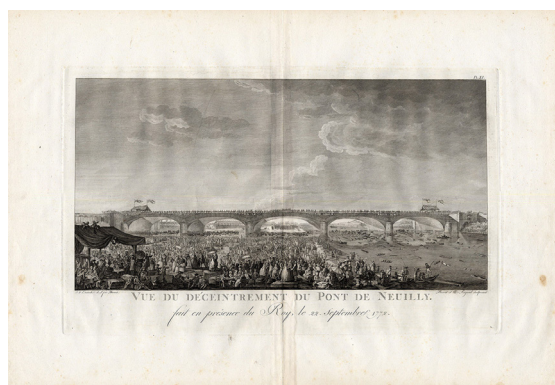
The Décintrement of the Pont de Neuilly
