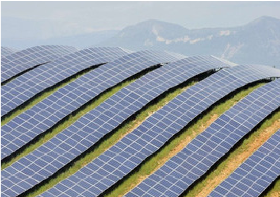
1/Technische elementen Energiewende
