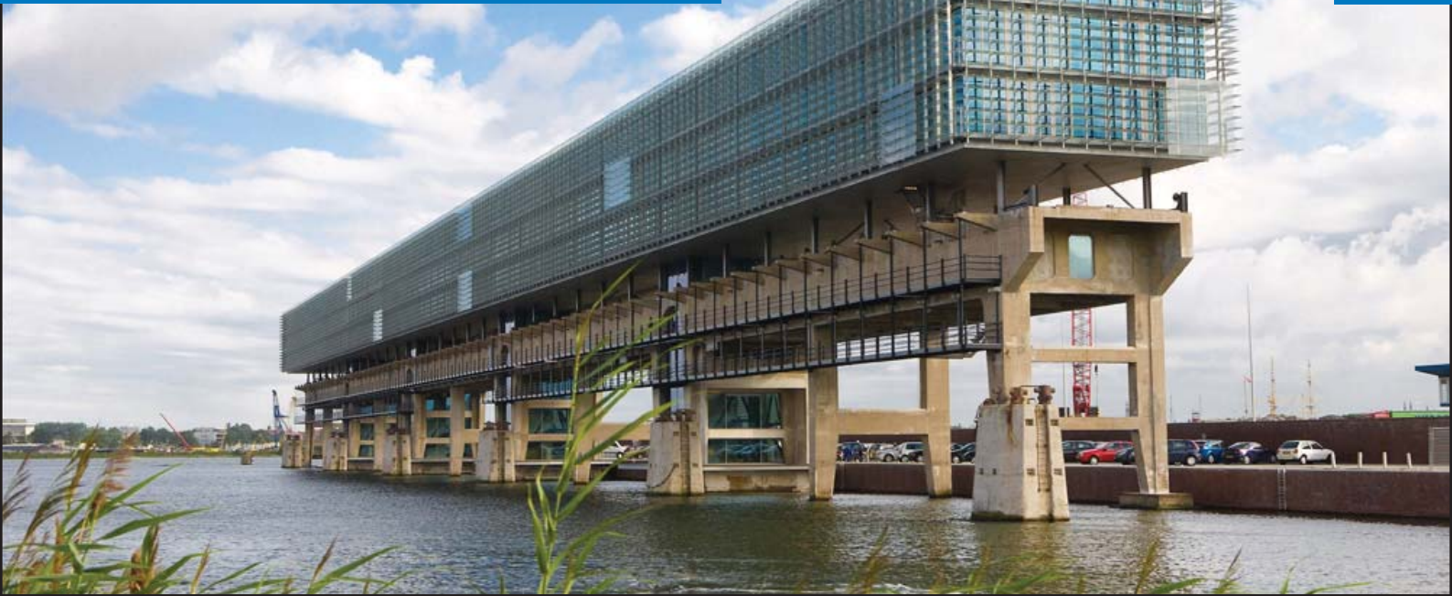
Afbeelding i: Kraanspoor, Amsterdam ( www.bouwenmetstaal.nl )
