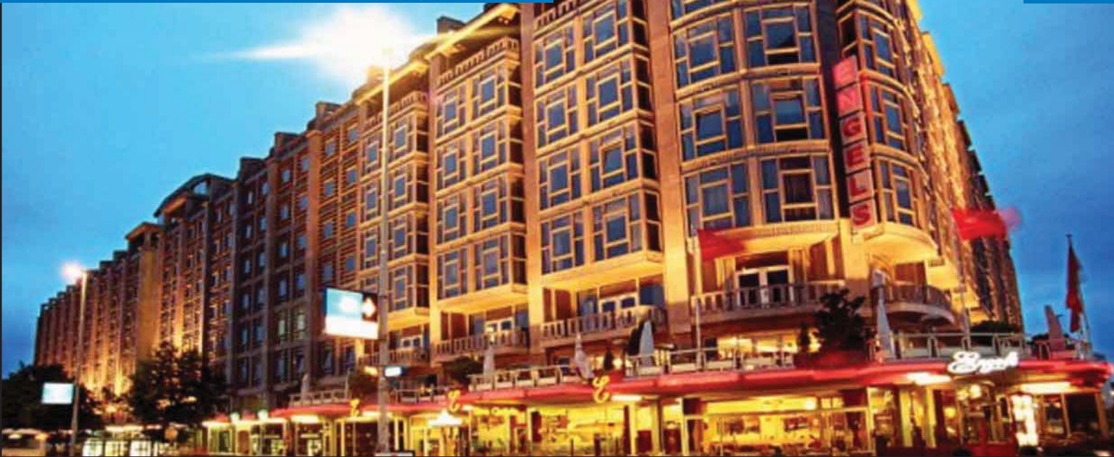
Fig. 49: Groothandelsgebouw - Architectenbureau J. van Stigt, Rotterdam ( www.denationaleklantmanagementdag.nl )
