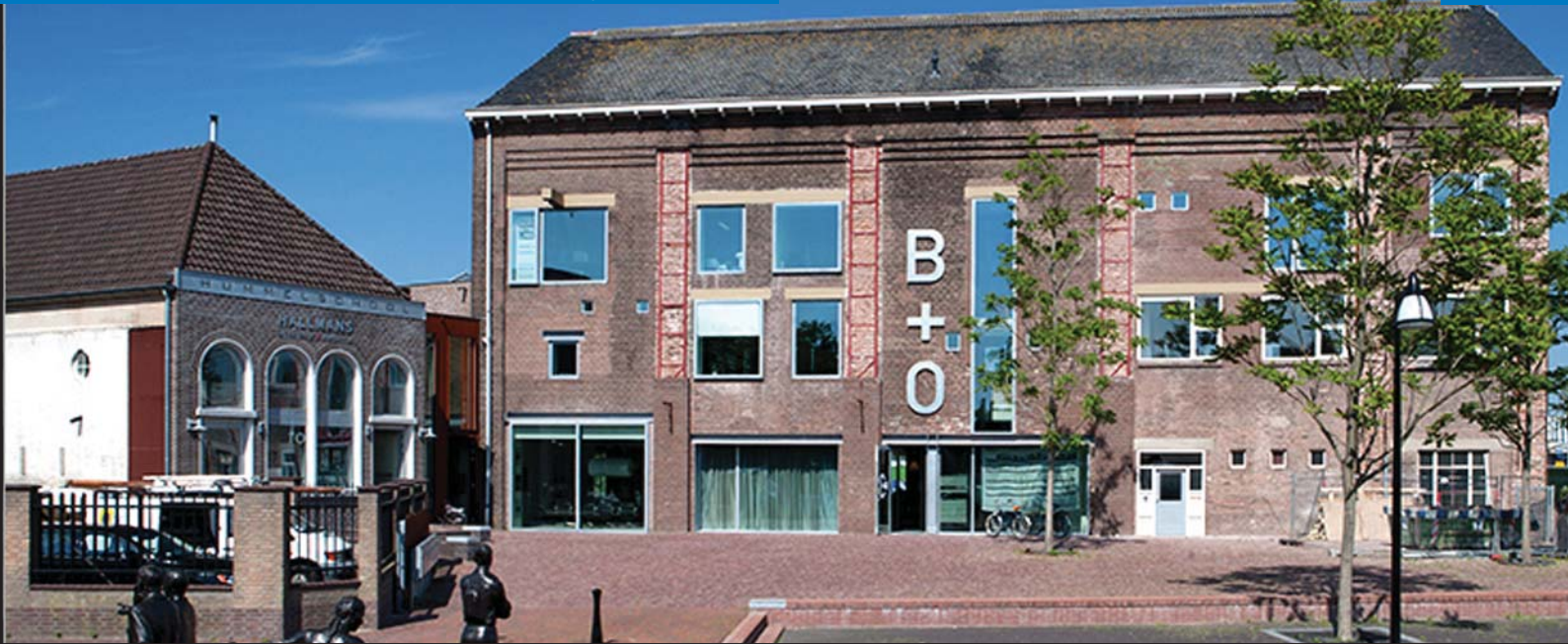
Fig. 57: Gasfabriek Meppel - B en O Architecten, Meppel ( www.drentsearchitectuurprijs.nl )
