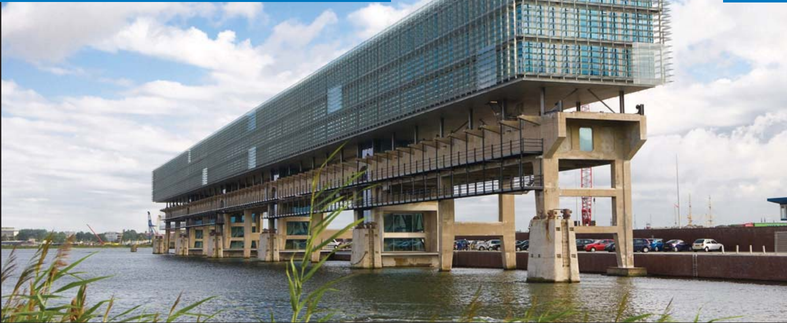
Afbeelding f: Kraanspoor, Amsterdam ( www.bouwenmetstaal.nl )
