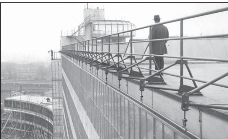
Fig. 54: Van Nelle Fabriek - L.C. van der Vlugt en J.A. Brinkman, Rotterdam ( www.vnof.nl )
