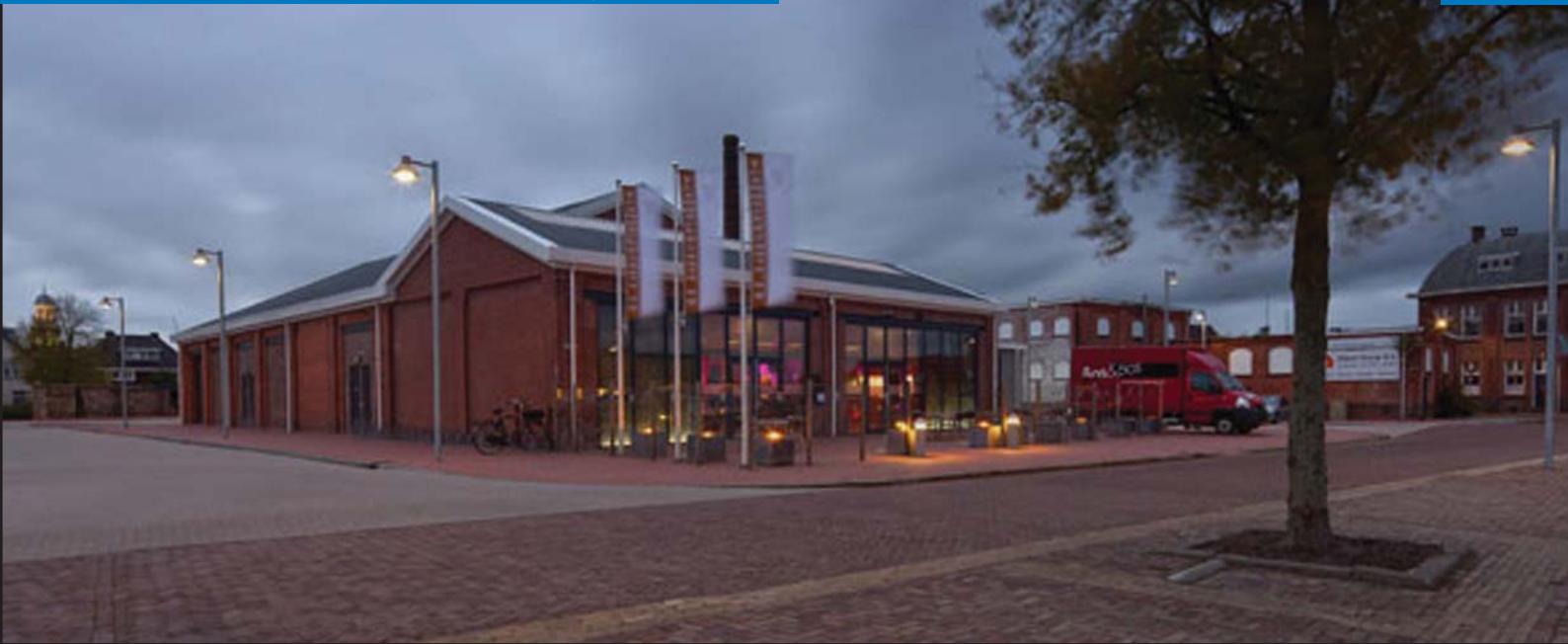
Fig. 24: Tramwerkplaats - KAW Architecten, Winschoten ( www.kaw.nl )
