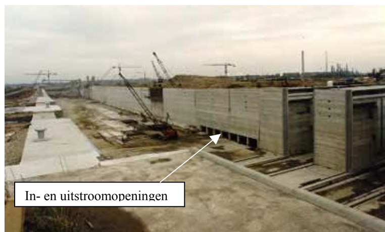
Foto 13.1: Diep gelegen in- en uitstroomopeningen in kolkwand.
