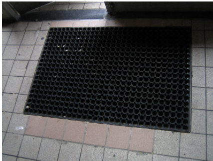
Figuur 4.4-m Tegelreparatie entree centrale hal
