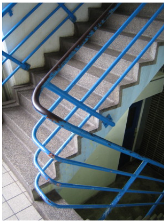
Figuur 4.4-n Trappenhuis met beneden een pishoek en een deur naar de bergingsgang.
