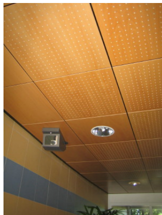
Figuur 4.6-c Verlaagd geluidsabsorberend plafond en nieuwe tegels
