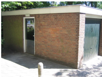
Figuur 4.5-e vuilruimte in garagebox Merelflat
