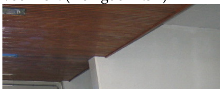
Figuur 4.5-f verlaagd schrootjesplafond Reigerflat
