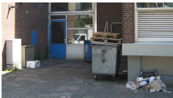
Figuur 4.4-e (Ondernemers)afval bij toegang 'noodtrappenhuis'
