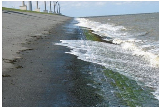
(c) Impervious asphalt revetment (Rijkswaterstaat, 2019).
