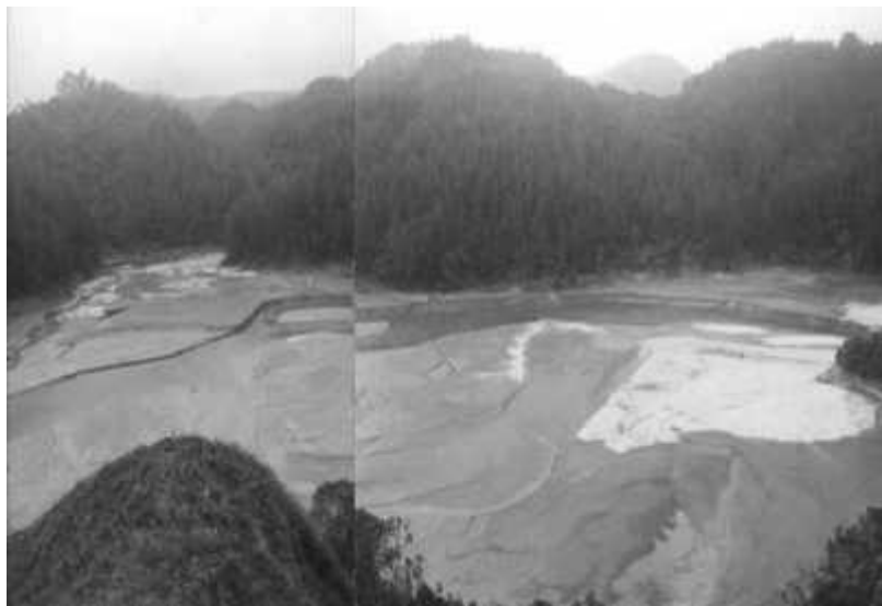
Figura 8.- Problemas de sedimentación en el embalse de Troneras. Fuente: http://fluidos.eia.edu.co/hidraulica/articulos/flujoencañales/mantenimiento_embalses/mantenimiento_embalses.html
