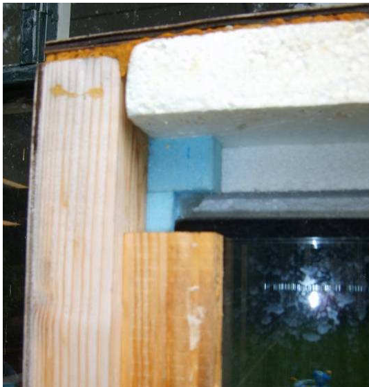
Figuur 5.12 Detail van aansluiting linkerbovenzijde. Boven het glas is een kier van ongeveer 10 mm zichtbaar
