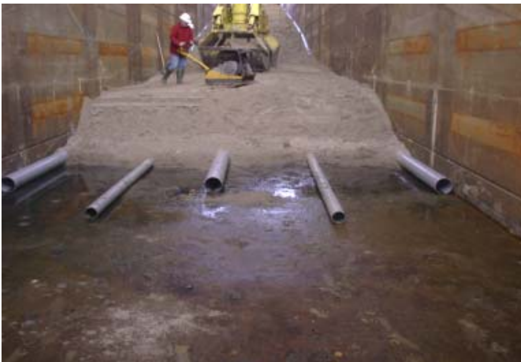
Dunne drainagepijpen en dikke overslagpijpen waarop zand in lagen wordt aangebracht en verdicht
