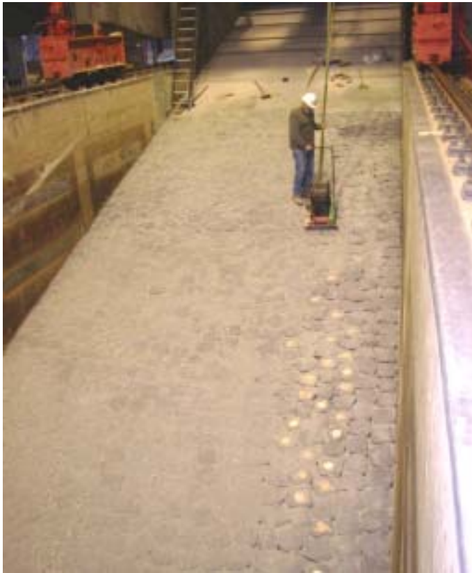
Basalton zetten en aantrillen
