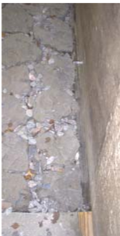
Indeuking rubber onderaan talud
