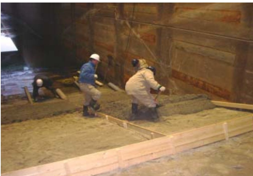
Beton aanbrengen op onderste deel van het talud
