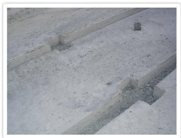
Figuur 19 Uitgespaarde ruimte in betonconstructie
