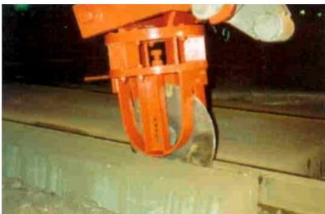
Figuur 24 Corkelast wordt losgesneden door middel van het "pizzames", vervolgens wordt het overige corkelast verwijderd
