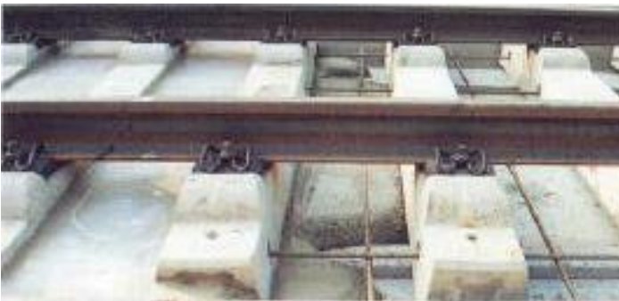
Figuur 7 Ingestorte dwarsliggersysteem
