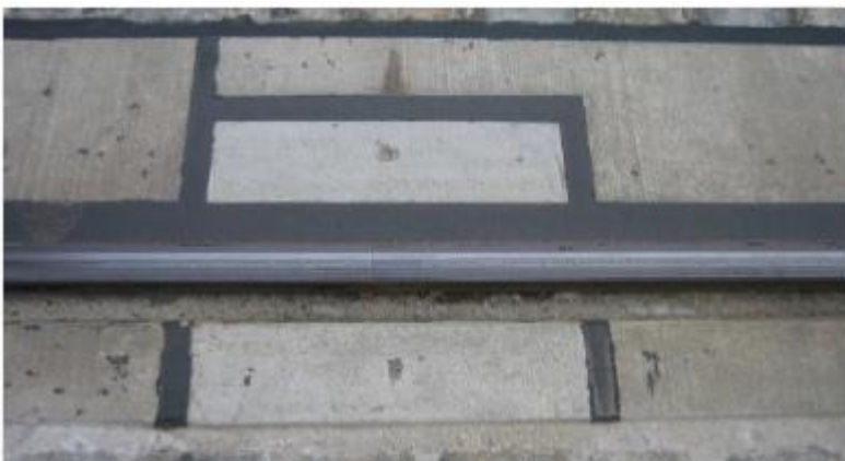
Figuur 23 Afwerking van de volledig ingegoten pocket en lasverbinding
