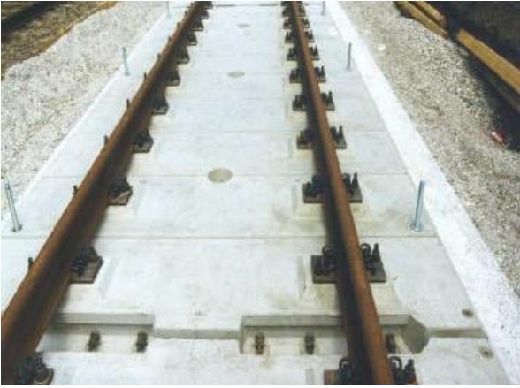
Figuur 6 Prefab Platenspoor
