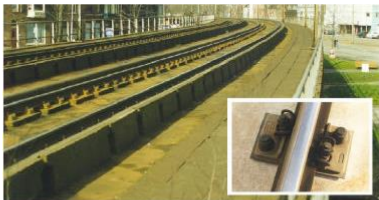
Figuur 5 Directe bevestiging op spoorviaduct Delft
