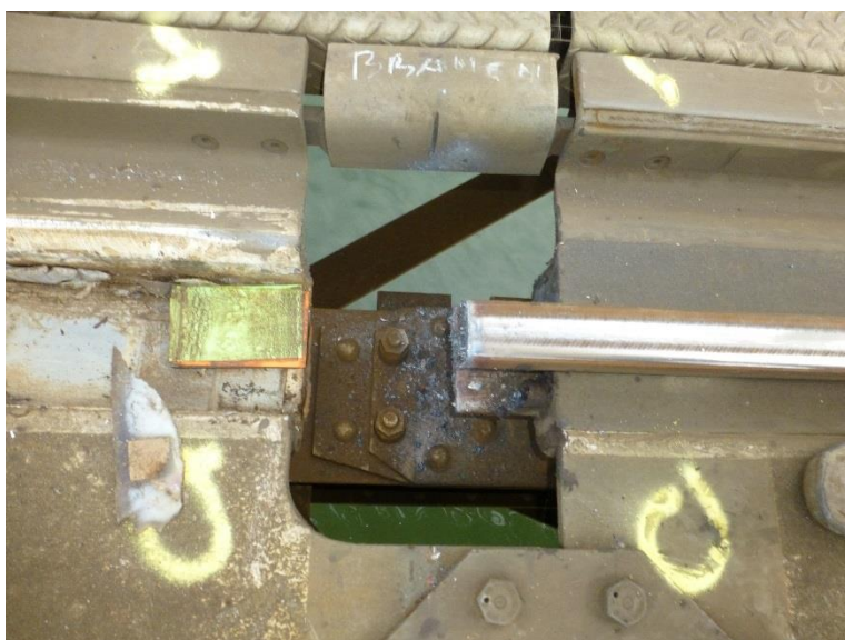
Figuur 17 Pocket waar een lasverbinding zal worden gemaakt
