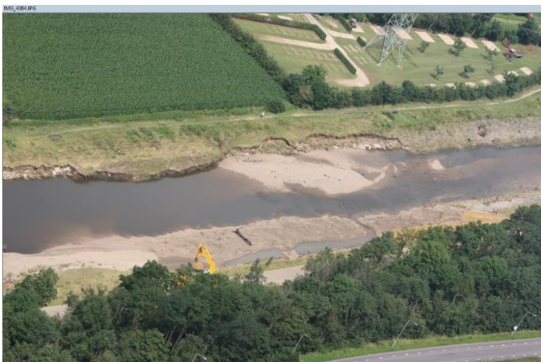
Figuur B.3.6.2: Helikopterfoto herstelwerkzaamheden
