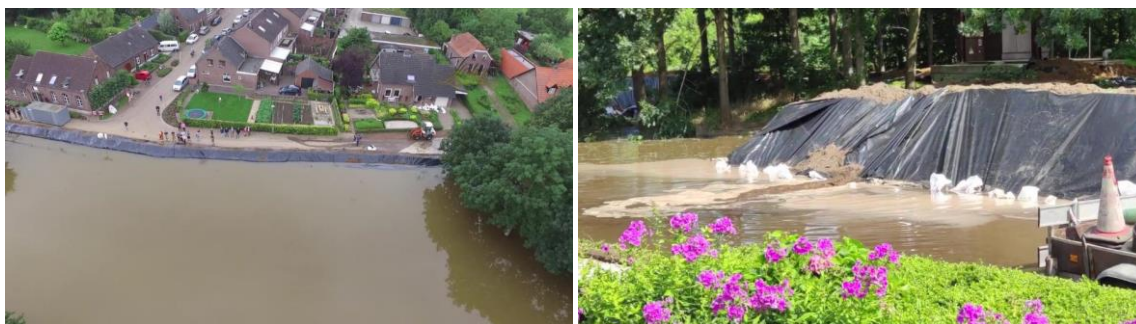
Figuur C.3.1 Nooddijk bij Horn 26 met de latere doorbraaklocatie bij de shovel, en het begin van de doorbraak 27 .
