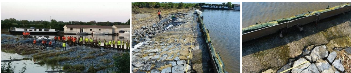
Figuur 4.8: Stuw bij Bosscherveld: noodreparatie met assistentie van het leger (foto Wilbur van Beijnen, Rijkswaterstaat), overzicht kering na reparatie (vloedmerken nog zichtbaar bij de begroeiing op de achtergrond), detail verankering stalen rand.
