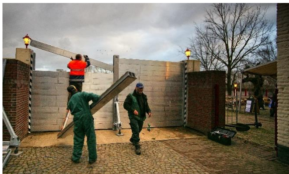
Figuur 7.5: Demontabele kering bij Steyl (tijdens oefening)
