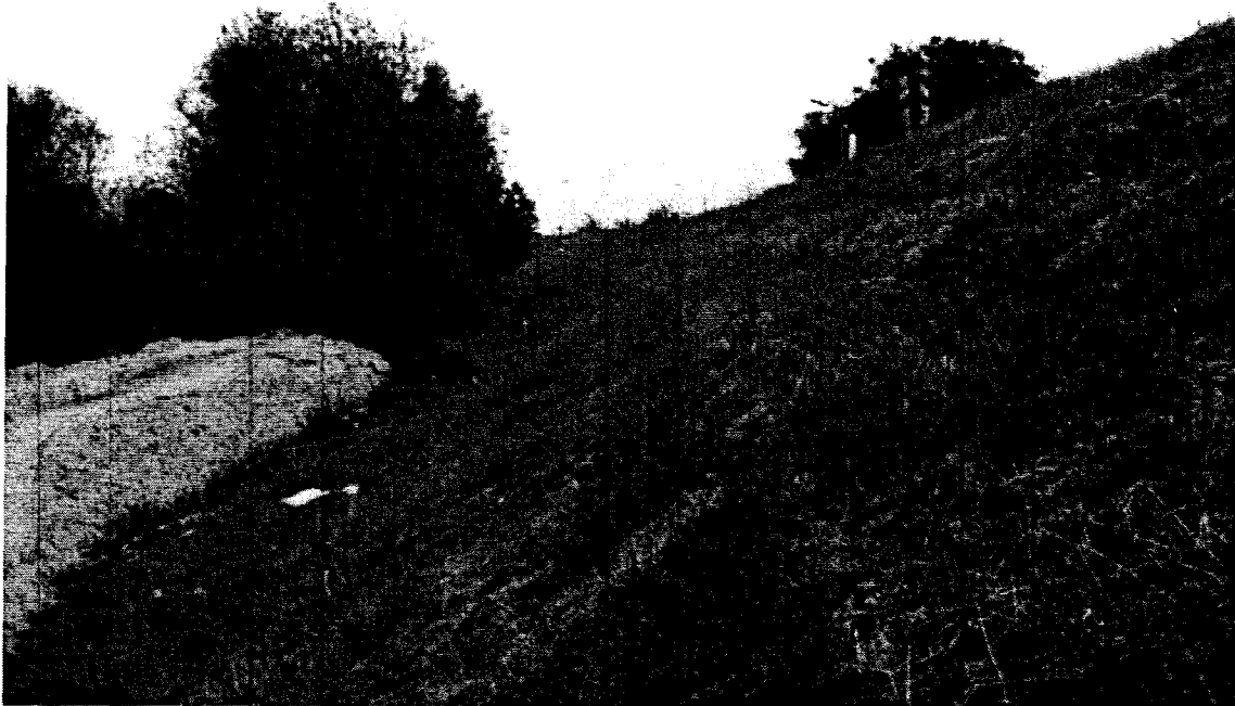
foto 17: Steil talud (minder dan 1:2) bij Tienhoven
