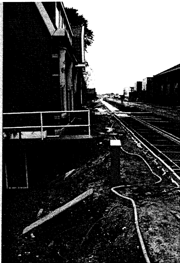
foto 28: Aanleg diepwand in Hardinxveld-Giessendam met links dijkwoning in het binnentalud
