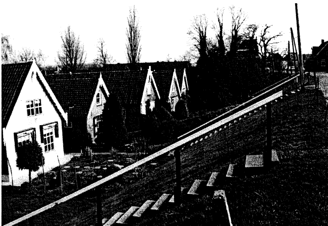
foto 38: Woning aan de teen van steil binnentalud (1:2)
