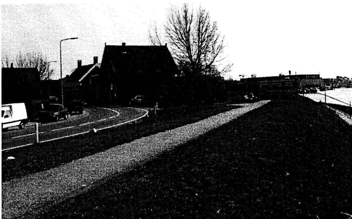
foto 50: Nieuwe dijk bij Alblasterdam
