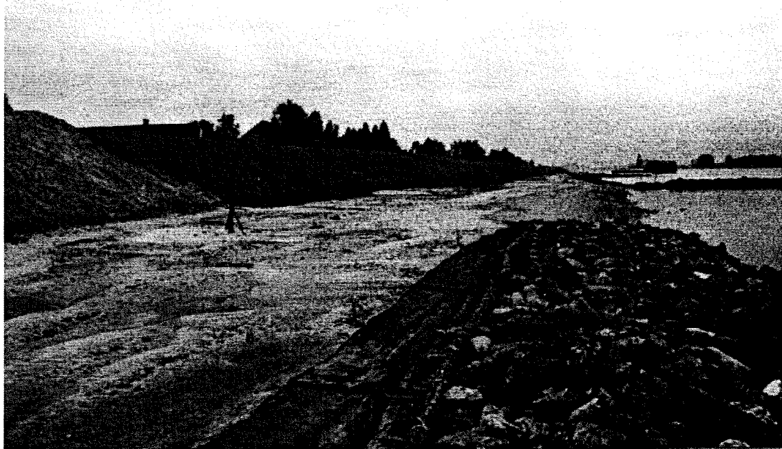
foto 16: Zinkstukken voor dijkversterking bij Langerak
