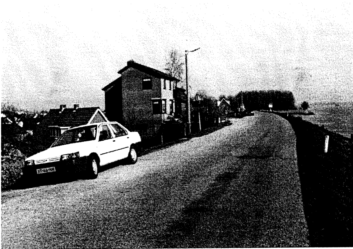
foto 33: Dijk net buiten Ammerstol, bebouwd binnentalud, geen voorland
