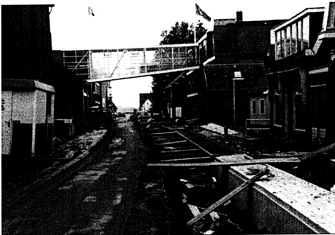
foto 27: Aanleg diepwand in Hardinxveld-Giessendam
