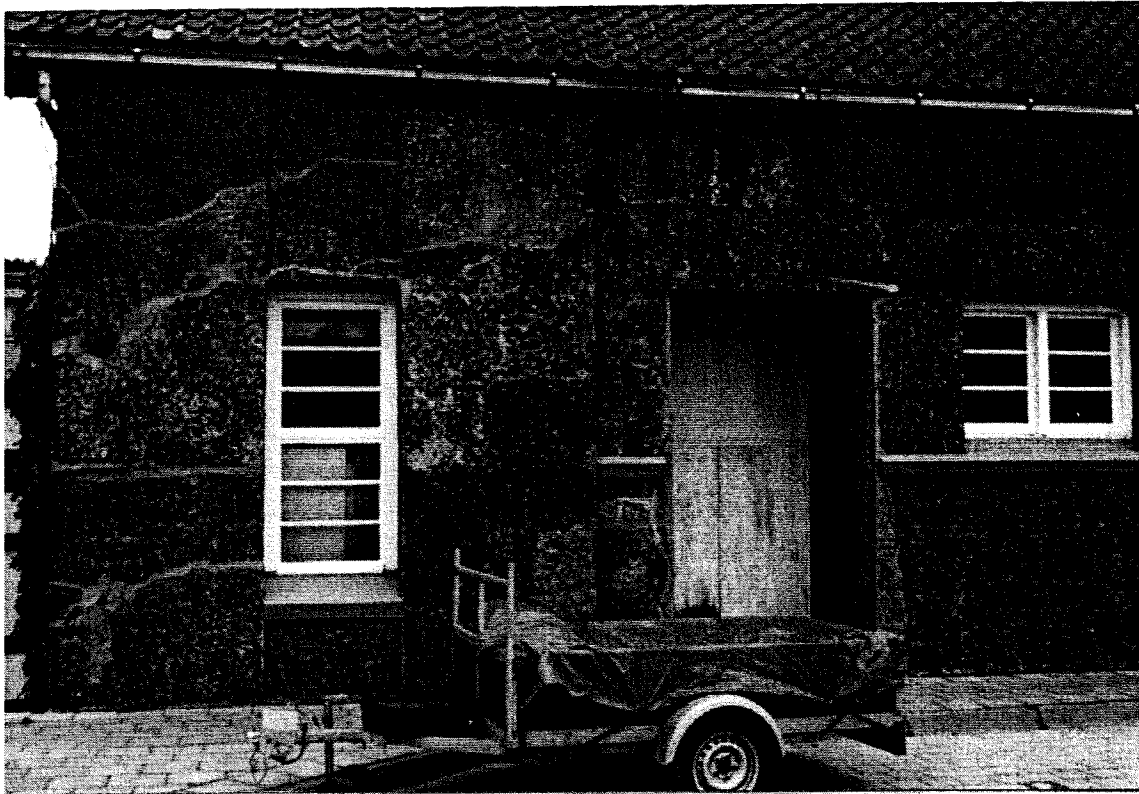
foto 11: Scheuren in dijkwoning in Kinderdijk
