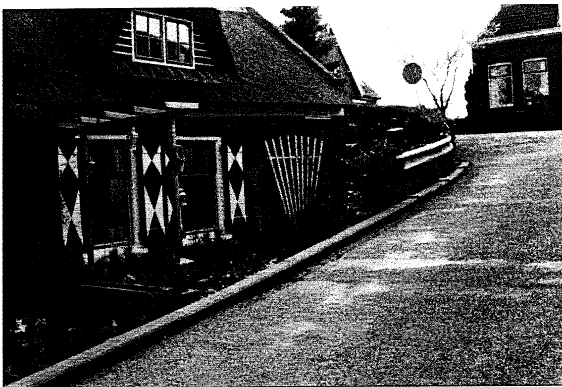
foto 35: Oprit naar de dijk vanuit de polder, links monumentale woning
