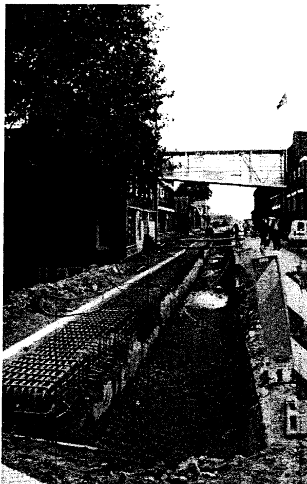
foto 26: Aanleg diepwand in Hardinxveld-Giessendam
