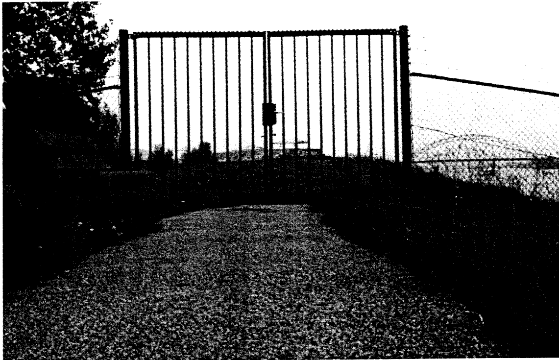
foto 3: Afsluiting verlegde dijk in Alblasserdam
