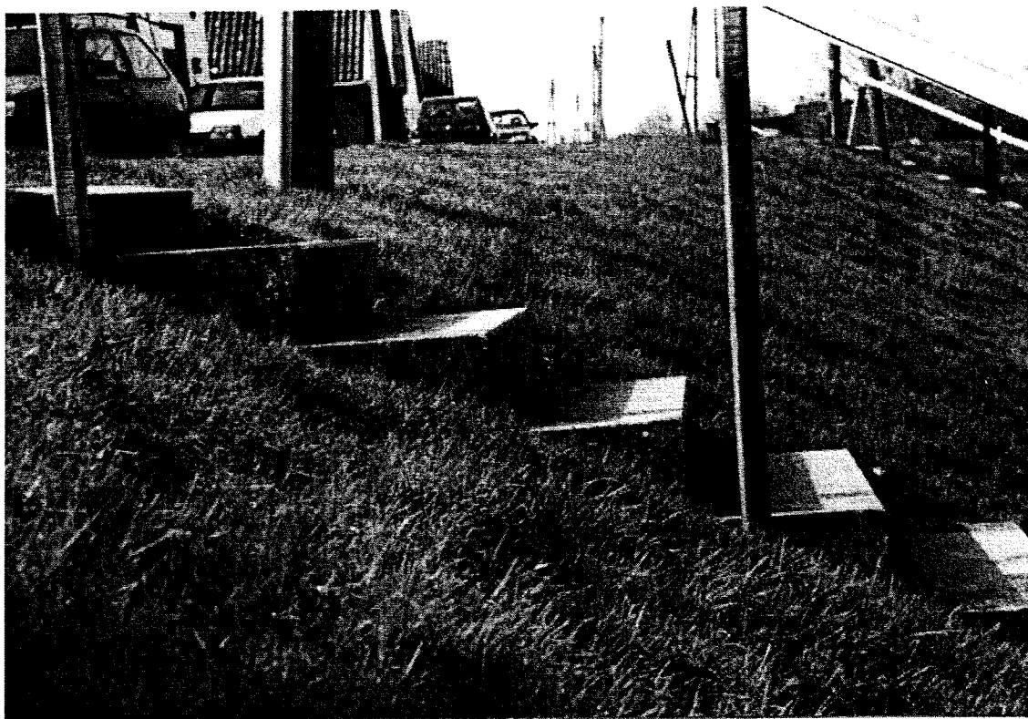
foto 39: Trap langs het binnentalud, illustratief voor de steilheid (1:2)
