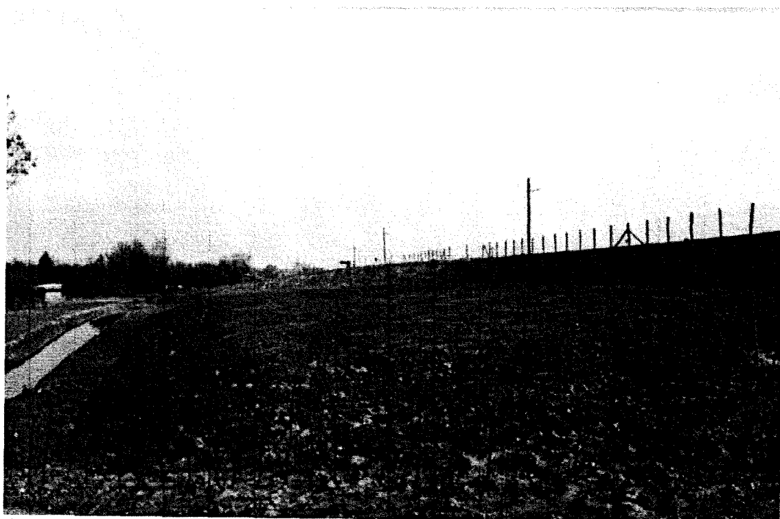
foto 46: Binnenberm met ontlastsloot achter nieuwe dijk
