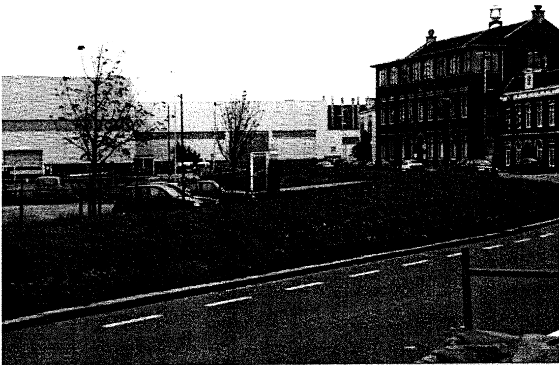
foto 10 Buitendijkse dijkverhoging in Kinderdijk
