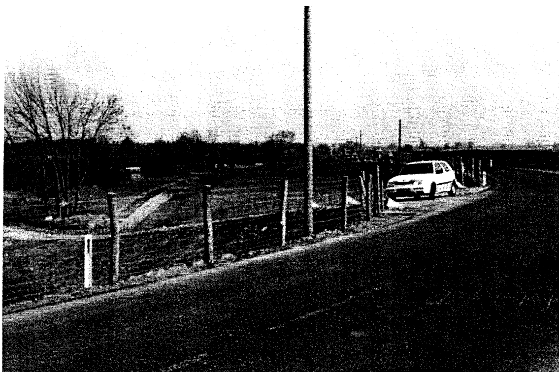
foto 44: Nieuwe dijk met binnenberm
