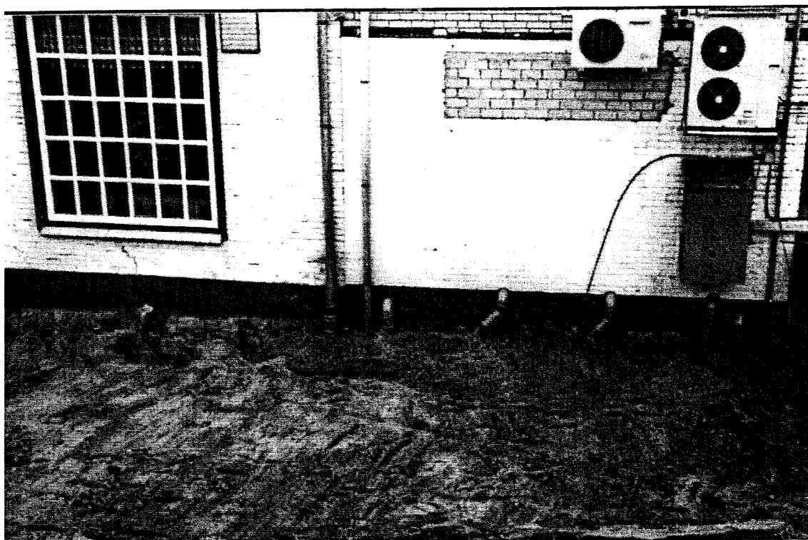
foto 23: Leidingen die problematisch zijn bij dijkversterking in Boven-Hardinxveld
