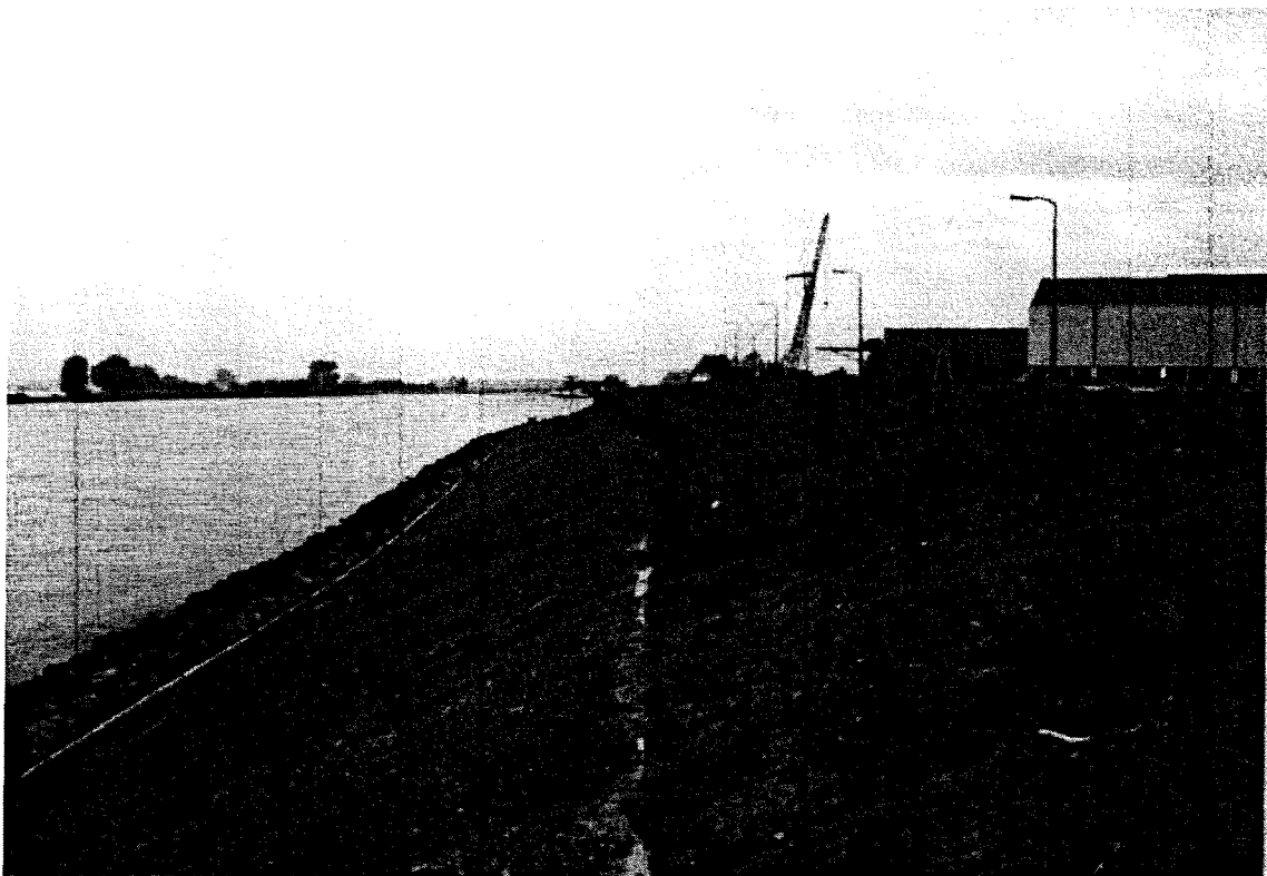
foto 22: Aanbrengen Asfaltverharing op buitentalud bij Boven-Hardinxveld
