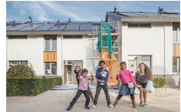
Energiesprong Kaalheide: snelle systeemrenovatie in bewoonde staat en in 7 dagen
