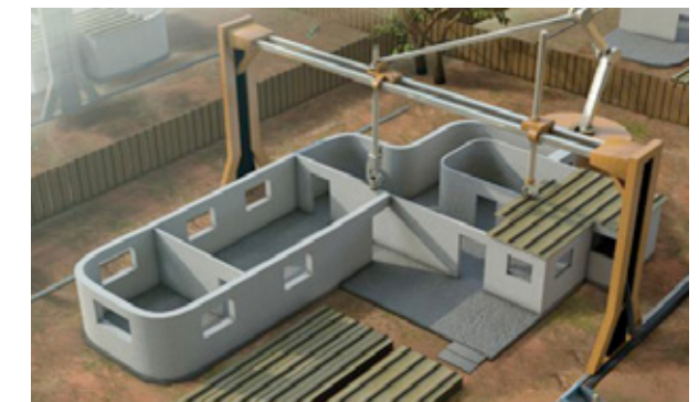
3d-printer bouwt huis in 24 uur
