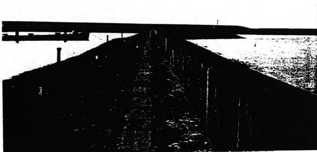
figuur 1-4 Ophoging oostdam met perkoenpalen
