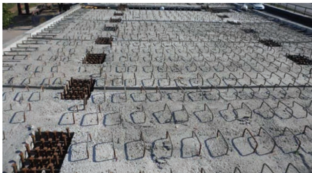
Slika 1. Primjena grupe moždanika u gradnji mostova
