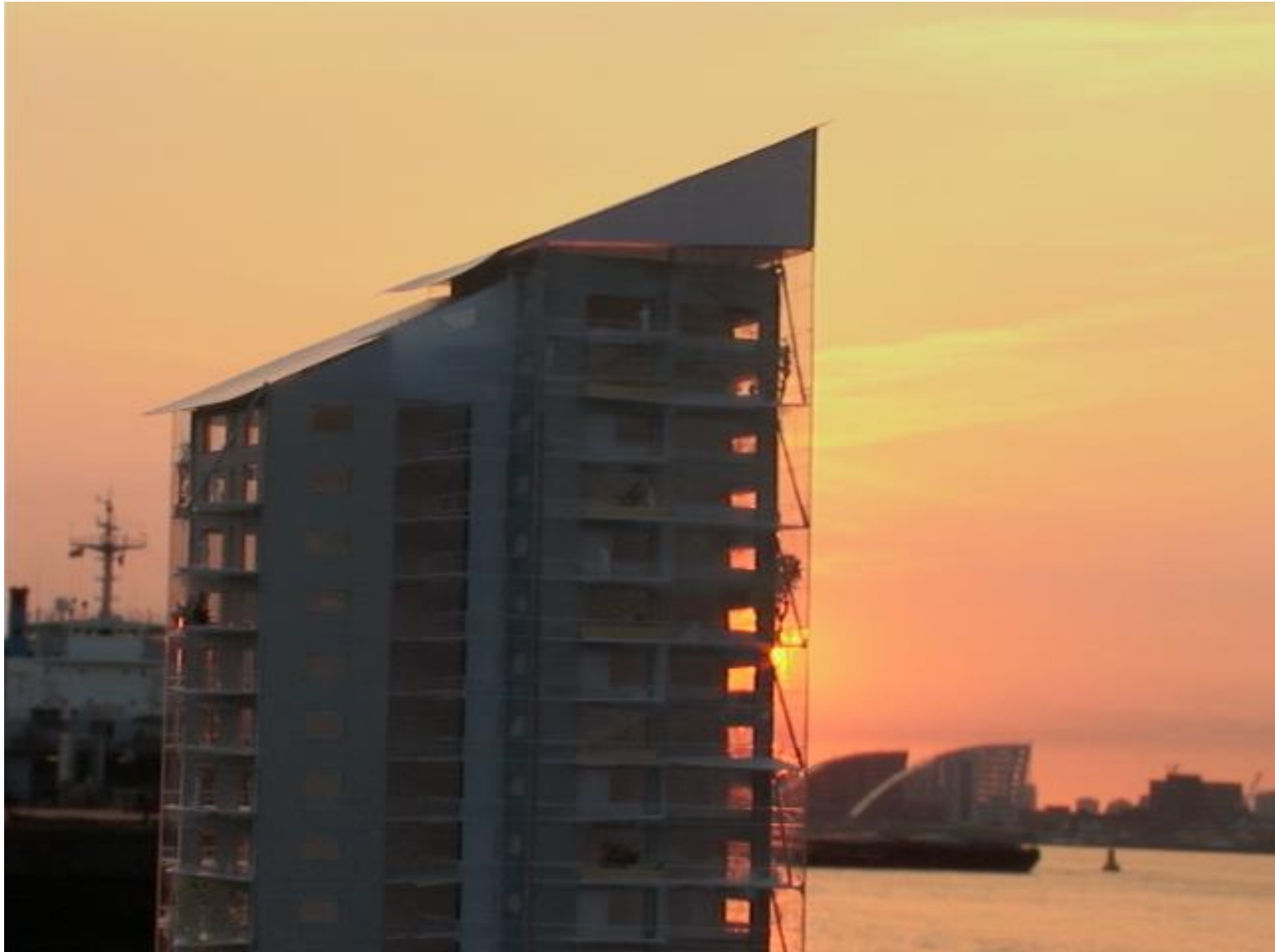
Gebouw op locatie
