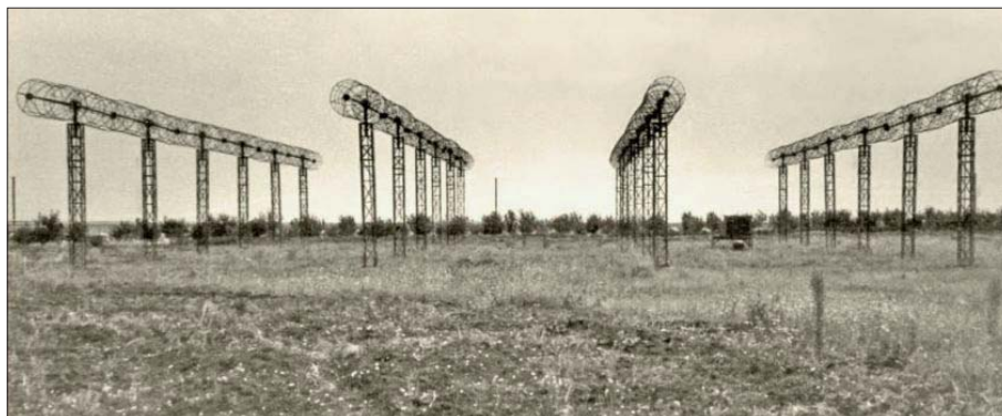
Фото 4. Перший в Україні тестовий 24-елементний радіотелескоп декаметрових хвиль ІД-1
