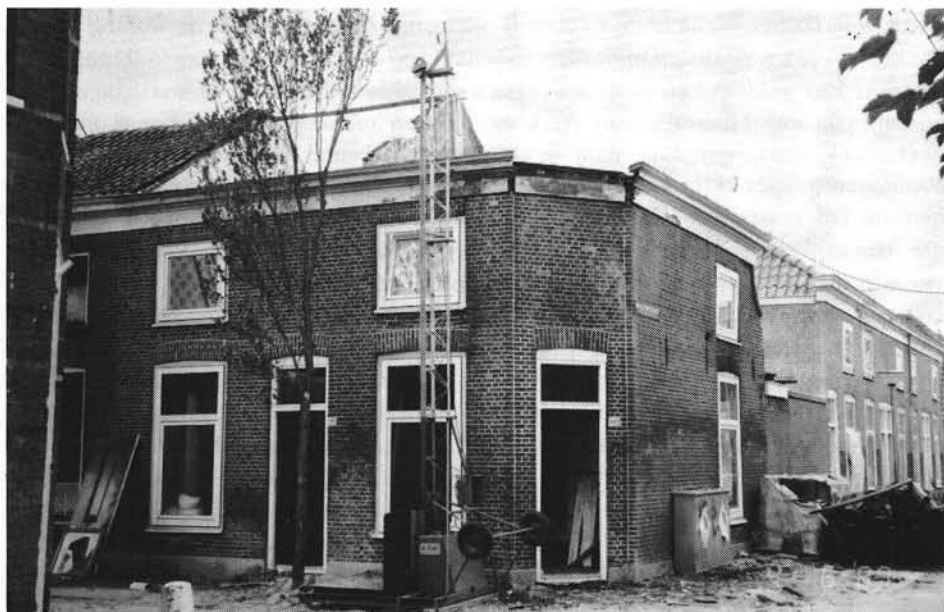
Uitvoering van verbeteringen aan het aangekochte bezit
