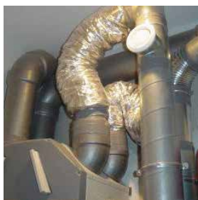
Afbeelding 2 (Installatie voor balansventilatie)
